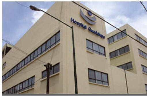
Fig. 2.0 Fachada actual del Hospital Guadalupe
