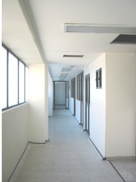
Fig. 2.3 Pasillo Área blanca
