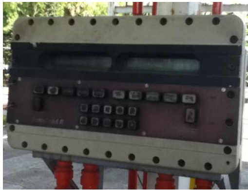
Figura III.4: Estado actual de la UCL de descargadera
