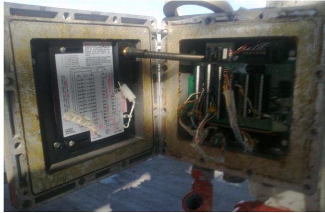
Figura III.2: Estado actual de la UCL por dentro
