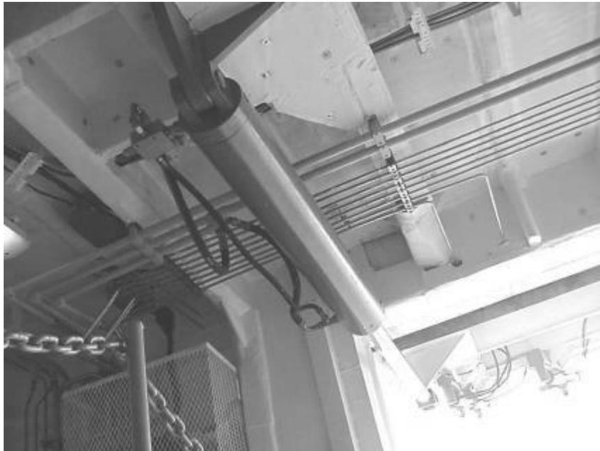
**Figura No.3.17, Cilindro hidráulico de 11" de diámetro por 1.20 M. de largo para la apertura de la compuerta uno en cada extremo. Fuente (archivo personal).**
