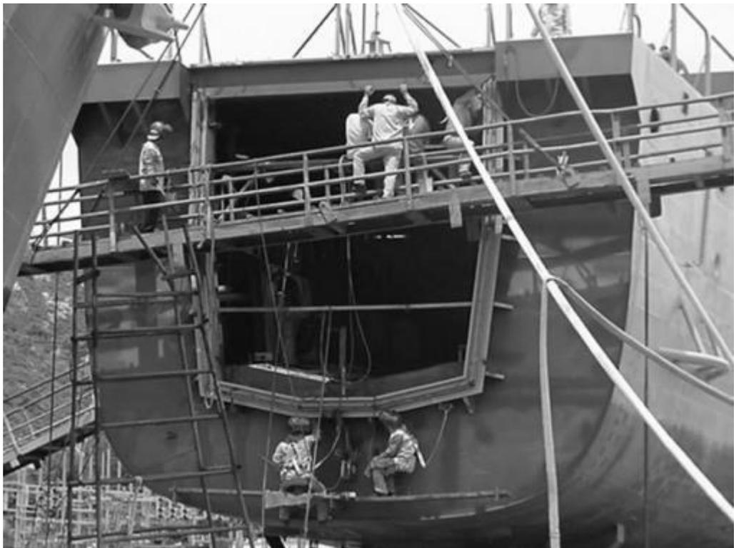
**Figura No.1.1 Marco de la compuerta en fabricación. (Parte de popa)**
