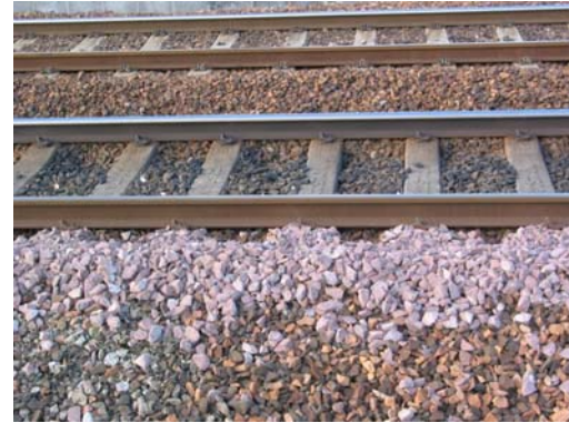
Fig. 10.2 Balasto constituido por rocas volcánicas su objetivo es, además, proporcionar una base drenante lo suficientemente estable como para mantener la alineación de la vía con un mínimo de mantenimiento
