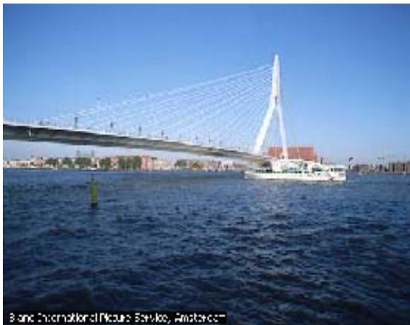
Fig. 3.1.2.10 Puente atirantado La ingeniería moderna ha sustituido los puentes colgantes por los atirantados, cuyos tirantes o cables de acero se sujetan directamente a la torre. Este ejemplo, el Puente Erasmo, en Rotterdam, salva una distancia de 800 metros y muestra la importancia del diseño de la torre, que se suele construir en hormigón armado. B and International Picture Service, Amsterdam Microsoft® Encarta® 2008. © 1993--2007 Microsoft Corporation. Reservados todos los derechos.
