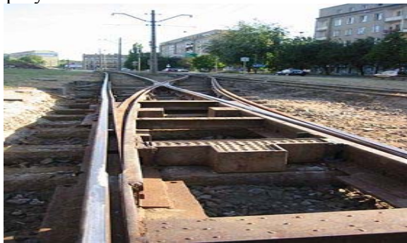
Fig. 1.2.2 aparato de vía (cortavías) 24
