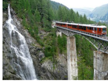
Estructuras complementarias a base de concreto 13
