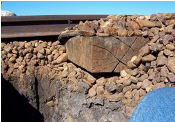
Fig. 1.3.9 Balasto y durmiente 58
