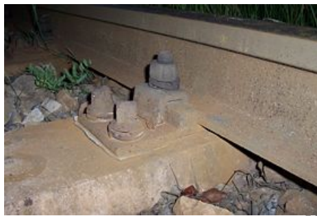
Fig.1.3.25a Sillita de asiento metálica 76, 77
