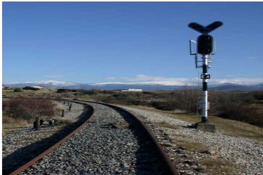
Figura 4.1.3 Señal luminosa colocada del lado derecho de la vía 5
