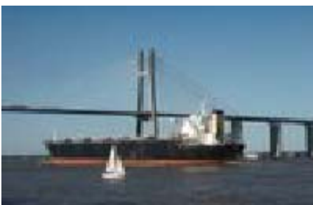
Fig. 3.1.2.3 En ménsula (Puente Rosario-Victoria), trabaja a tracción en la zona superior de la estructura y compresión en la inferior. Los puentes atirantados (foto) son una derivación de este estilo.
