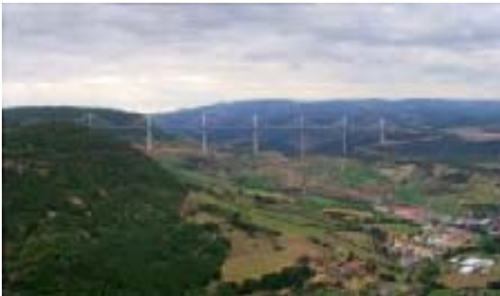
Fig. 3.1.2.5 Puente colgante en Millau, Francia, es el puente más largo del mundo con una longitud de 2460 m. http://es.wikipedia.org/wiki/Imagen:Wiadukt_Millau.jpg
