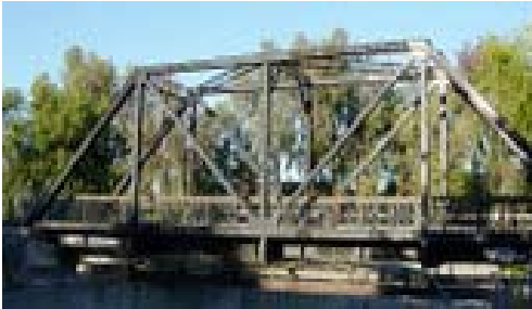
Fig. 3.4.3 Puente a base celosías planas en sus caras construido para un antiguo ferrocarril (ahora convertido en puente peatonal) http://es.wikipedia.org/wiki/Imagen:RRTrussBridgeSideView.jpg
