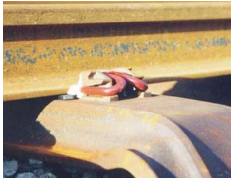
1.3.17 Riel con sujeción pandrol 67
