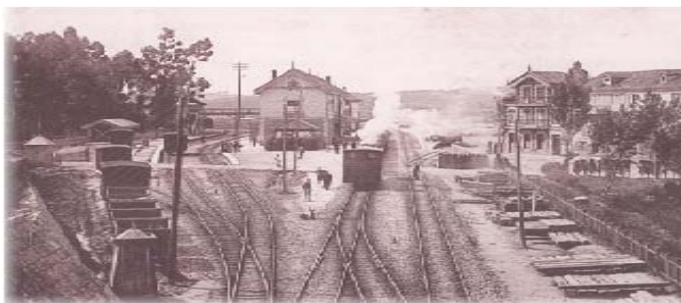
Fig. 1.1.1.10 Tren en vías de Santander-Bilbao. A la izquierda se encontraban las vías del Astillero-Ontaneda. Año 1909. Foto: Tarjeta postal (se puede observar un ladero, un peine) 20
