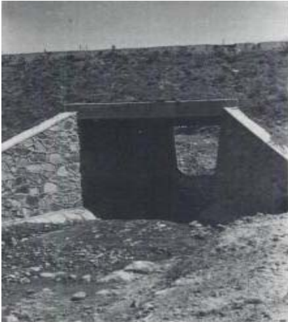
Fig.3.1.1 Alcantarilla típica en una carretera. Losa de concreto Referencia Bibliográfica:
