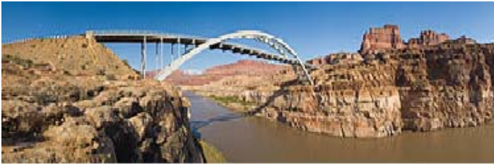
Fig. 3.1.2.1 Puente sobre el río Colorado, en Estados Unidos.
