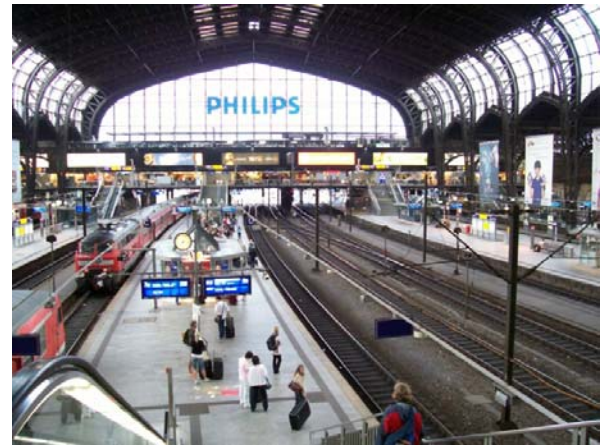
Fig.4.2.3.-Terminal de trenes Hamburgo 24
