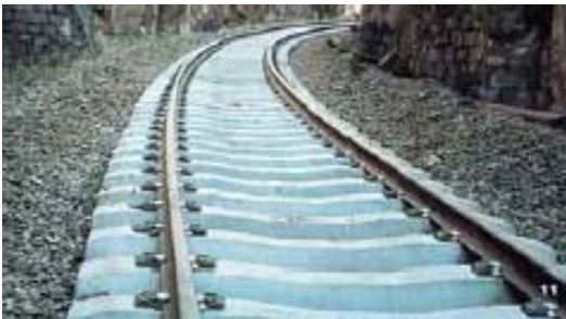
Fig. 3.7.14. Durmientes de hormigón.
