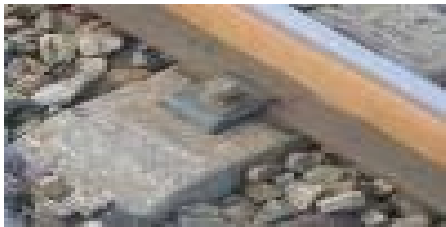
Fig. 3.7.17 Sistema de sujeción P2 http://es.wikipedia.org/wiki/VÃ-a_fÃ©rrea
