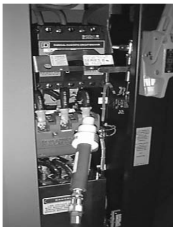
Fig. 3.33. Medición de EMI conducida In Situ [2].
