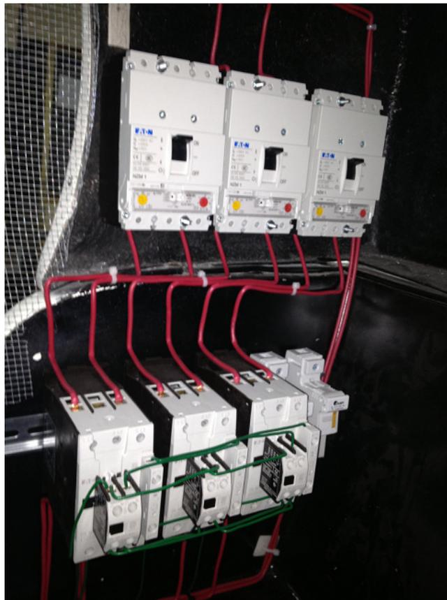
Figura 4. 35. Conexión de la Protecciones.
