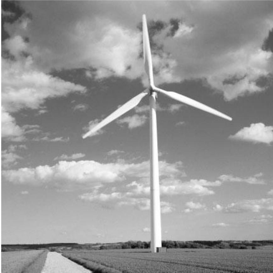
Figura 1.3 Aerogenerador de 48 m de Diámetro del tipo “danés” y 750 kW, en Dinamarca.
