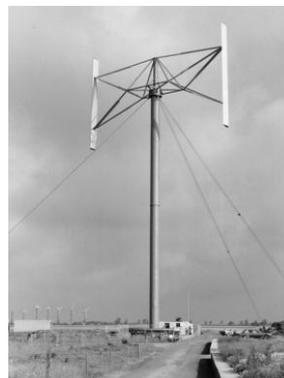
Figura 1.9 Aerogenerador vertical rotor H (35 m de diámetro, 300 kW)
