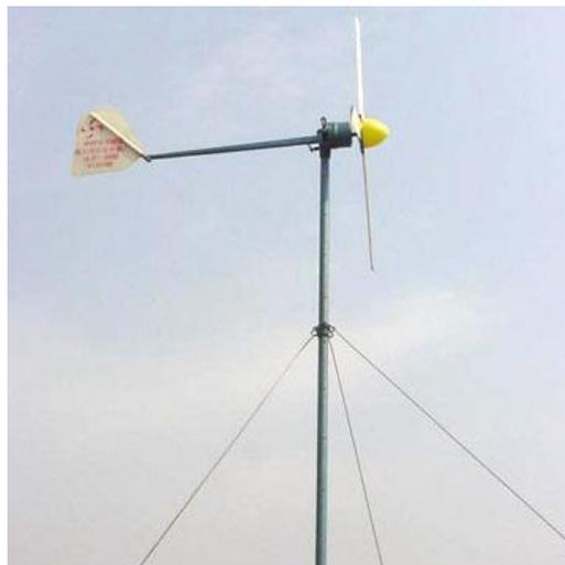
Figura 1.12. Turbina de baja potencia (6.5 m de diámetro, 5 kW)
