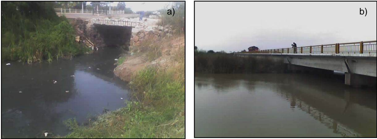
Figura 7. Detalle de las estructuras donde se efectuaron los muestreos en los drenes a) Mochis y b) Batequis.
