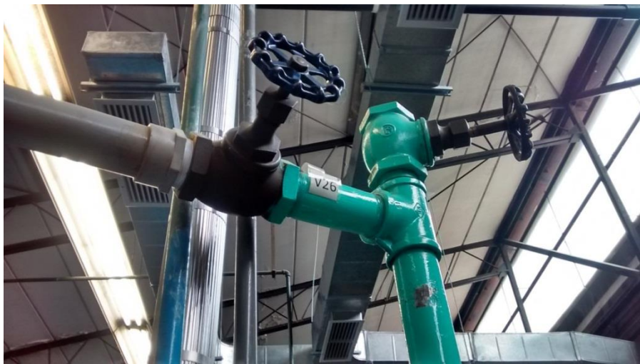
Figura 3.4. Válvula de globo que ventea el aire del soplador a la atmósfera, ESQIE-IPN.
