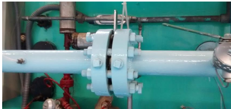
Figura 3.6. Placa de orificio, ESIQIE-IPN.
