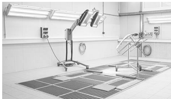
Figura 1.11 Caseta de reparaciones mayores
