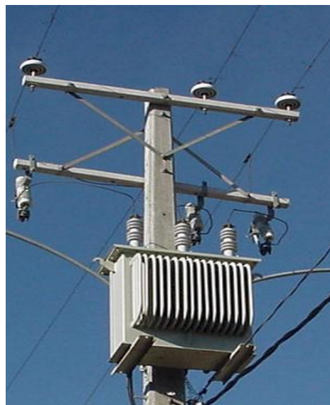
3.8 TRANSFORMADOR TIPO POSTE
