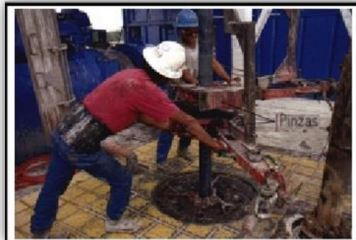
Figura 5.33 Llaves o pinzas de torque (Diplomado de Perforación, Esteban Vázquez Morales, Grupo AGP, 2013).
