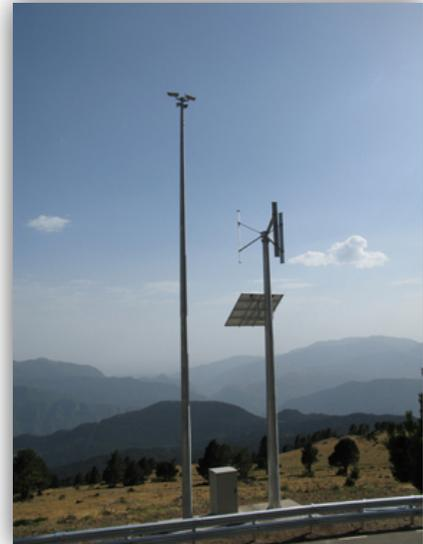
Figura 4.1. Cámara de video vigilancia con alimentación de una batería y cargador.
