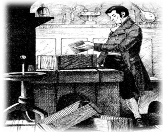
1.5 Primera Batería Inundada. William Cruickshank, químico Inglés, construyó una batería de pilas eléctricas uniendo planchas de zinc y cobre en una caja de madera llena de una solución de electrolitos. Este diseño inundado tenía la ventaja de que no se seque con el uso y proporciona más energía que la disposición del disco de Volta.
