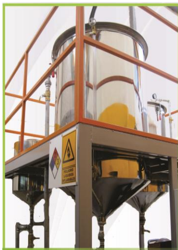
Figura 39. Planta semi-industrial para la producción de biodiésel. (Fuente: bio-diesel GRIMA, 2015)
