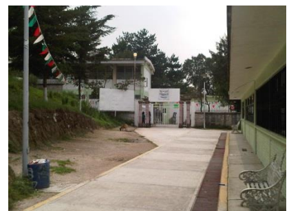
Imagen del equipamiento existente
