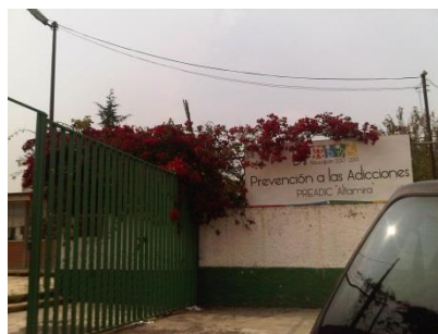
Imagen del equipamiento existente
