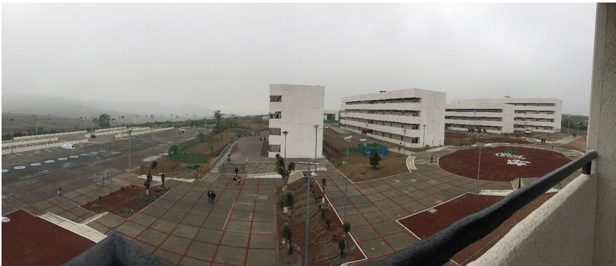
Anexo 4. Fotografía Edificios 1 (derecha), 2, 3, 4 y 5. Laboratorios Ligeros (costado derecho) de la Unidad Profesional Multidisciplinaria de Hidalgo del IPN
