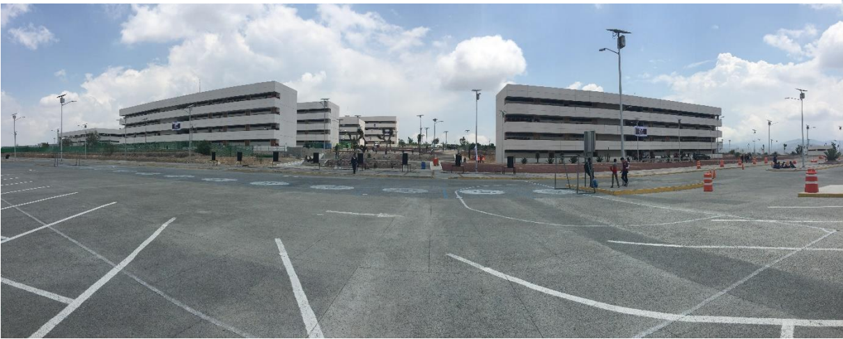
Anexo 5. Fotografía Edificios 2,3,4 y 5. Al fondo entre edificio 1 y 2 Laboratorios Ligeros del Cecyt 16 “Hidalgo”
