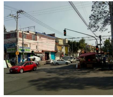
Ilustración 9 Postes de energía eléctrica y teléfono, cruce de cables en la inspección de la Av. Papalote y Escuinapa
