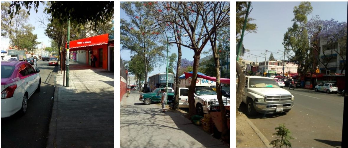
Ilustración 23 Estado de la Av. Escuinapa
