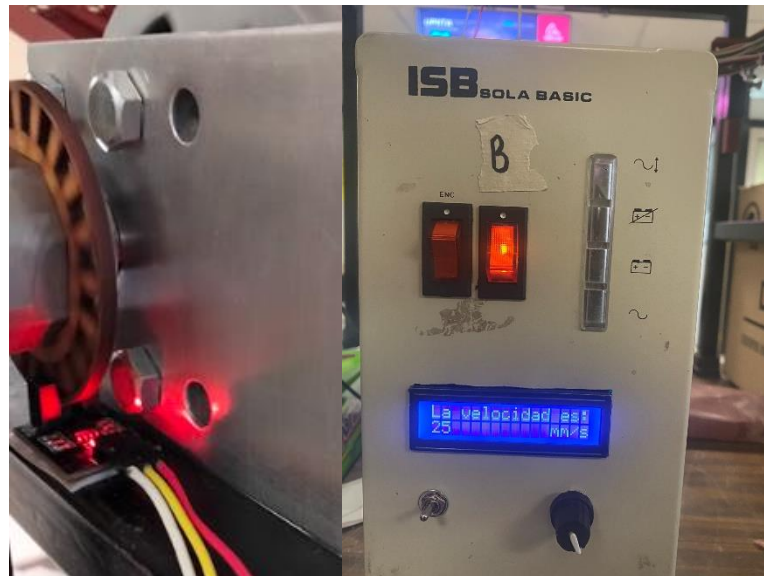
Ilustración 97 Acoplamiento del motor de accionamiento con encoder [Elaboración propia]
