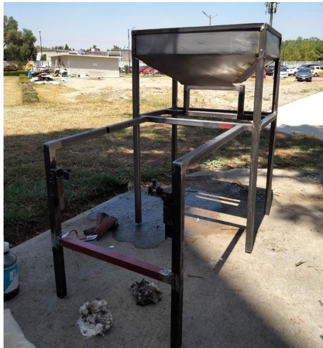
Ilustración 77 Estructura de la máquina y tolva instalada
