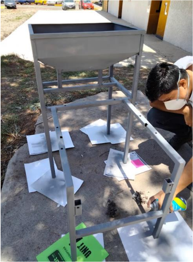
Ilustración 78 Aplicación de primario a la estructura
