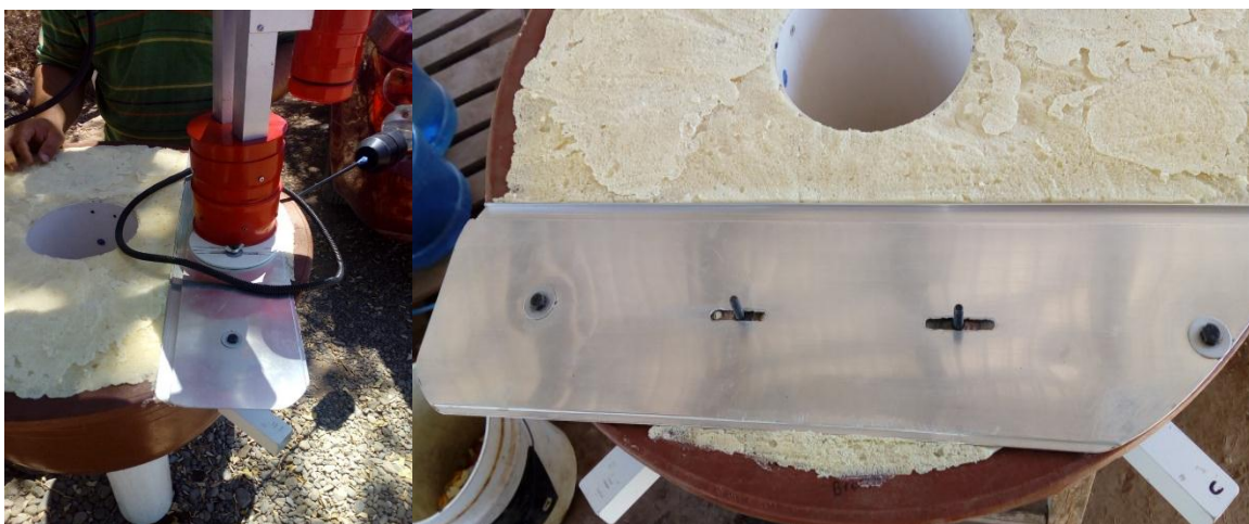
Figura 5. Instalación de las placas de aluminio y tornillos de acero inoxidable
