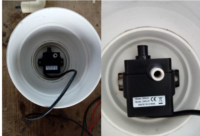
Figura 26. Instalación de la bomba y pegado de coples de 4 pulgadas
