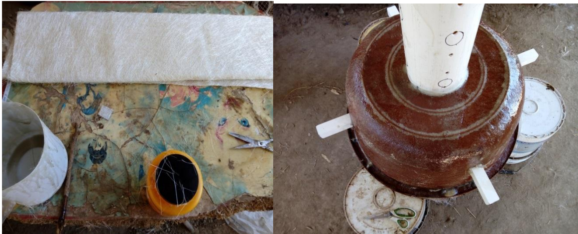
Figura 6. Aplicación de la tela de fibra de vidrio y resina epóxica
