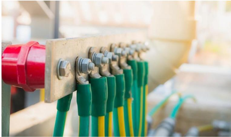
Figura 34: Ejemplo de un sistema de puesta a tierra. [Fuente: msinet.com.ar]
