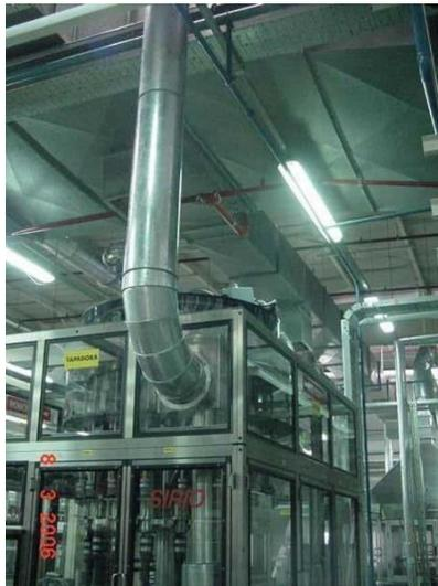
**Figura 7: Sistema de ventilación. Extracción de gases dentro de los gabinetes de llenado de etanol con fragancia. [Fuente: González y Rangel].**
