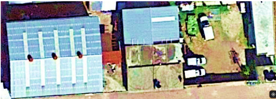
Fig. 3.2 Foto Satelital del Predio (Ampliación). [26]
