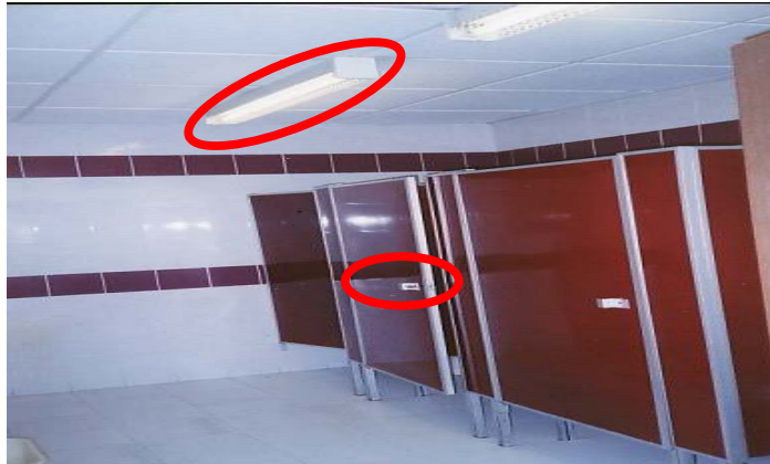
Foto 3. Sanitarios de Mujeres del Edificio de Pogrado. Fuente: Propia.
