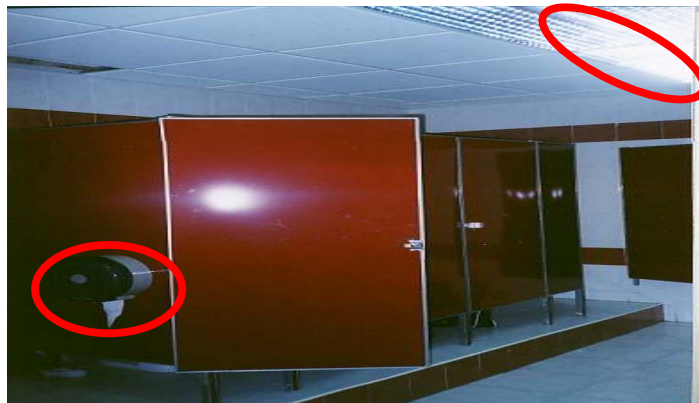
Foto.2. Baños del Edificio del Gobierno. Fuente: Propia.
