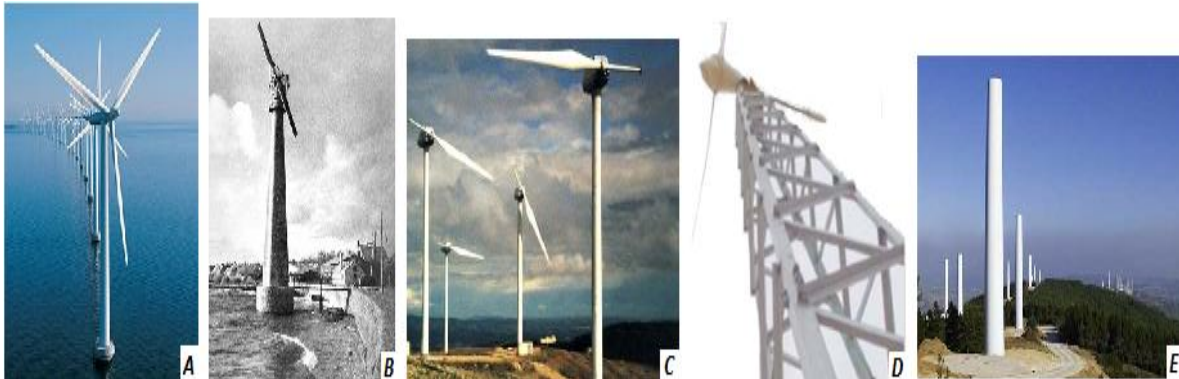
Fig. 14 Aero-turbinas horizontales (A. Tipo Tripala, B. Tipo Bipala, C. Tipo Monopala, D. Tipo Torre de Celosía 13 , E. Tipo Torre Tubular).
