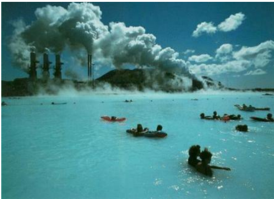
Fig. 23 Planta de energía geotérmica. (The Blue Lagoon; Grindavik Islandia).
