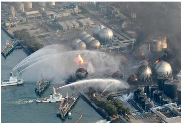
Fig. 4 Vertido de agua en la central nuclear de Fukushima.
