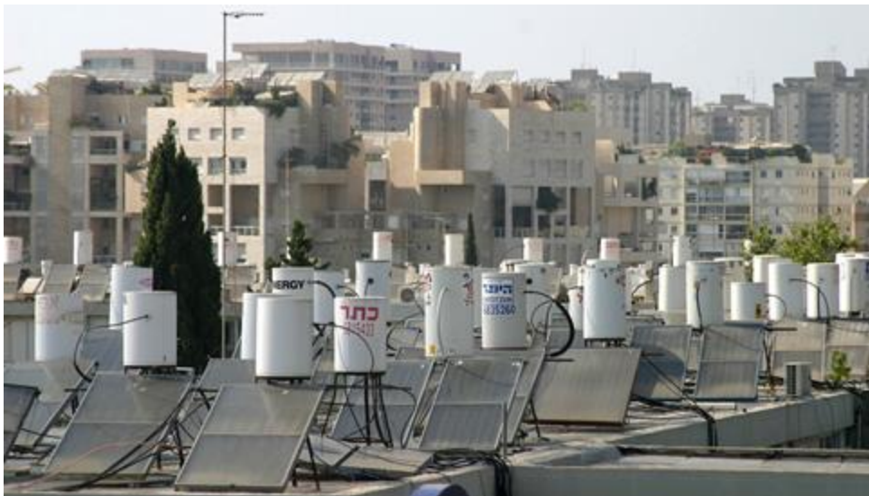
Fig. 25 Calentadores Solares de Agua (Chipre e Israel).
