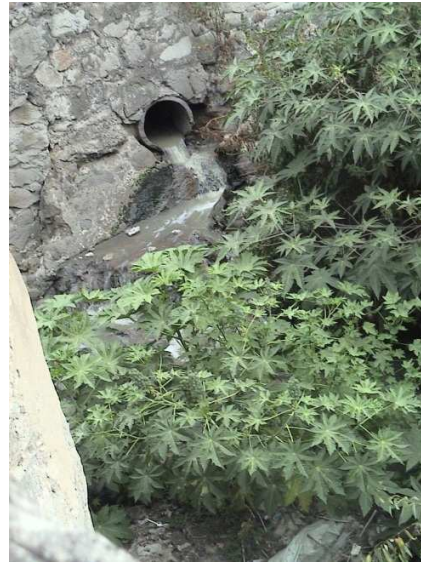
Fig. 5.2.2. Río Chico los Remedios, alimentado por descargas de aguas residuales domésticas. Fuente: elaboración propia.
