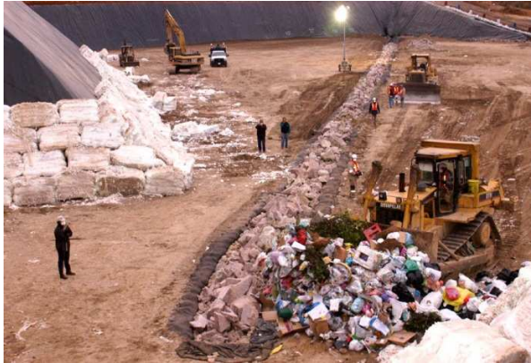
Figura.3.1.5. Vista del acondicionamiento del Relleno Sanitario sobre el tiradero a cielo abierto Rincón Verde, año 2006.
