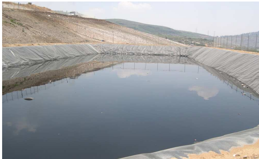
Figura 3.1.2.4 Laguna de captación de lixiviados del relleno sanitario de Santiago Tepatlaxco. Fuente: Elaboración propia
