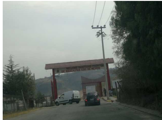
Figura 3.1.6. Vista de la entrada al Relleno Sanitario, Enero de 2012. Fuente: elaboración propia.
