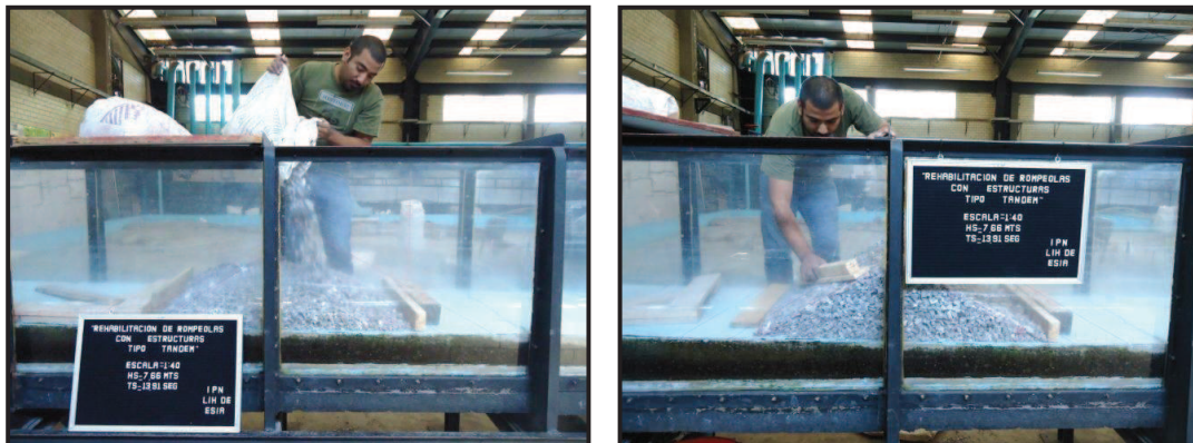
Figura IV.12. Colocación de material para el núcleo del rompeolas superficial.
