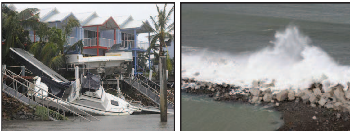
Figura II.7. Daños en marina y en rompeolas por el rebase del oleaje extremo.
