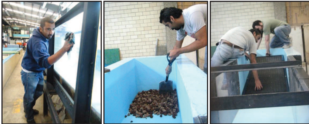
Figura IV.3. Limpieza de acrílicos, acomode de tezontle y colocación de amortiguador rehabilitado.
