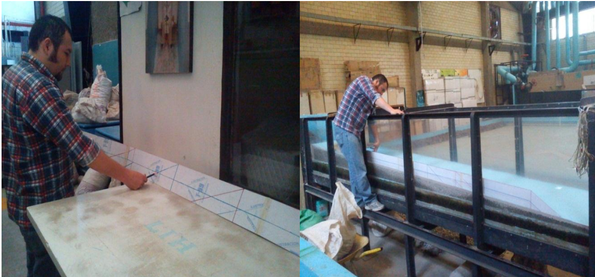
Fig.5.12. Implementación del escantillón para la correcta construcción de la estructura.
