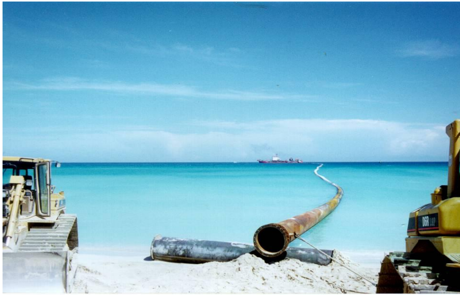
Fig. 3.1. Alimentación artificial de arena [www.yucatan.com.mx].
