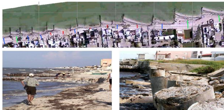
Fig. 2.18. Estructuras para intentar mitigar el daño.
