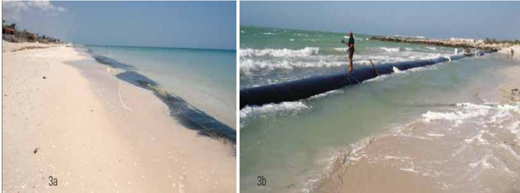
Fig. 2.23. Instalación de Geotubos en Chelem, Yucatán [Alvarez - Ricalde, 2006].
