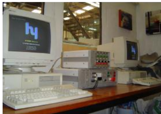
Fig. 5.4. Equipo de cómputo de control.
