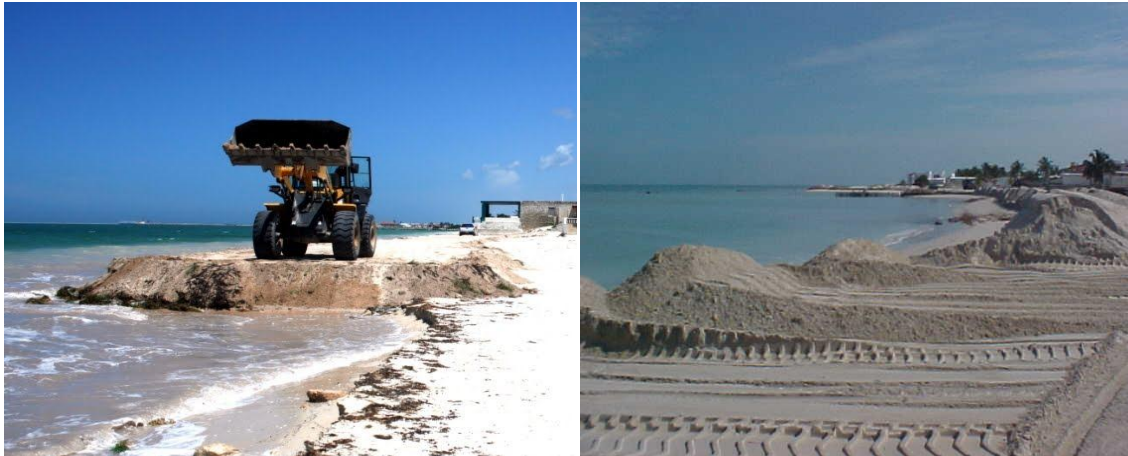
Fig. 2.24. Recuperación de playa mediante alimentación artificial en Chelem Yucatán [www.progresoahoy.com].
