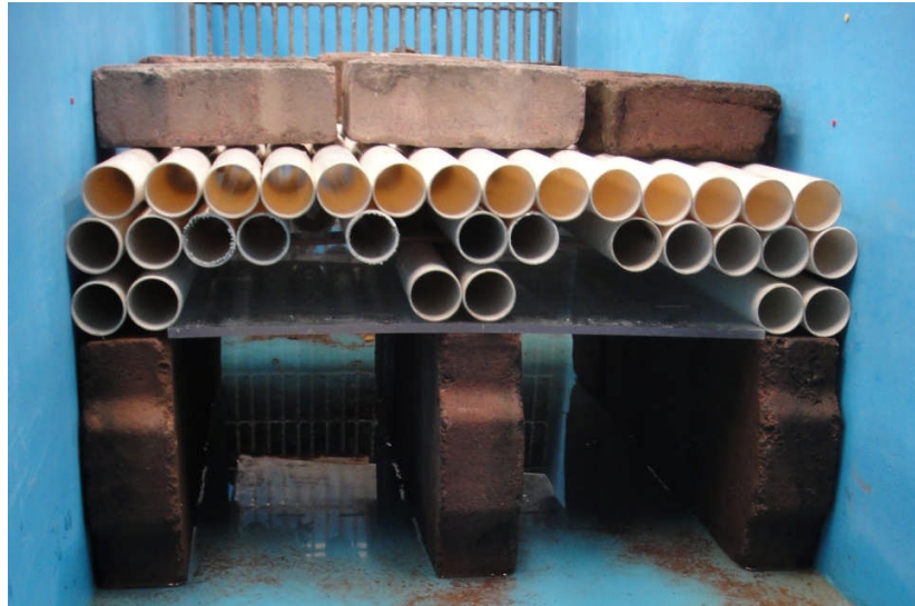
FIGURA 55. Direccionadores de flujo a la entrada del canal de aforo.
