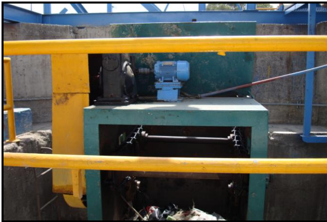
Figura II.3.1 Sistema de rejillas en obra de toma
