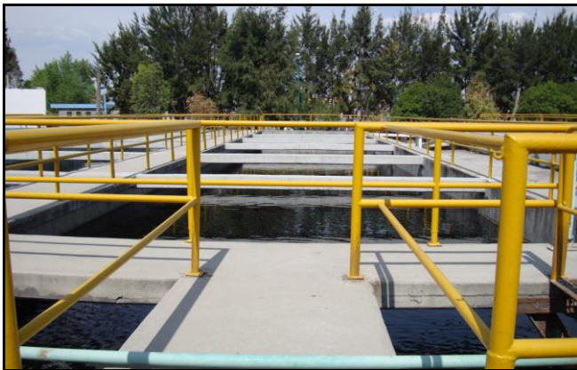
Figura II.5.2 Sedimentador secundario
