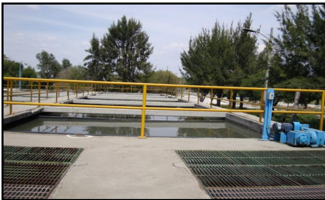
Figura II.4.3 Sedimentador primario
