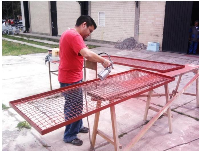
Figura 22. Aplicación pintura del amortiguador de oleaje.
