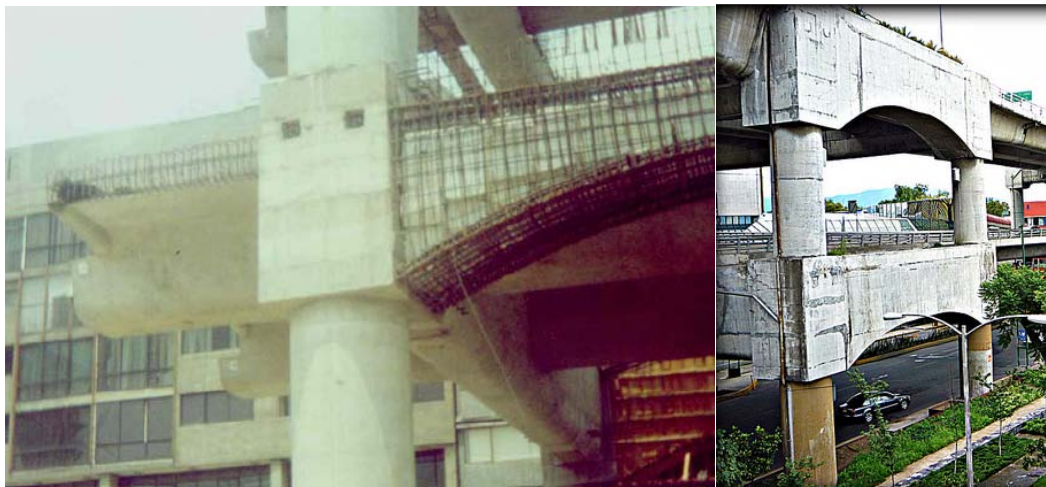
Figura 2.17 Armado de trabe de rigidez primer nivel.
