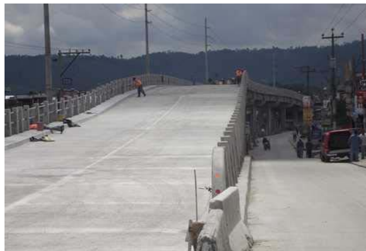
Figura 2.21 Acabado final en distribuidor vial.
