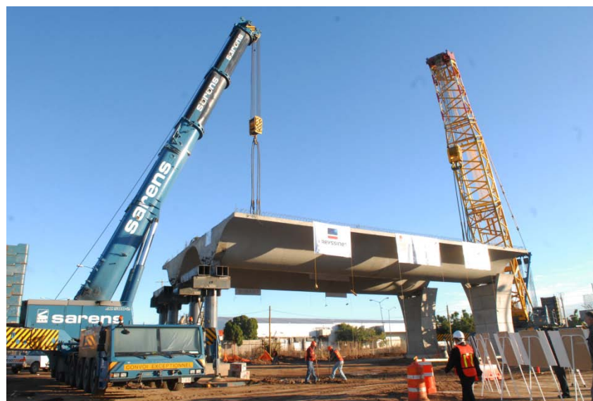
Figura 2.19 Trabe central tipo cajón.
