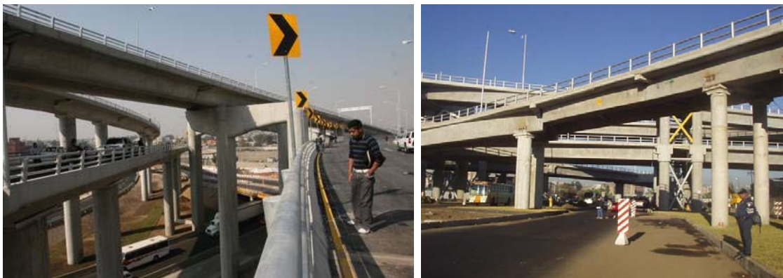
Figura 2.22 Distribuidor Vial Heberto Castillo
