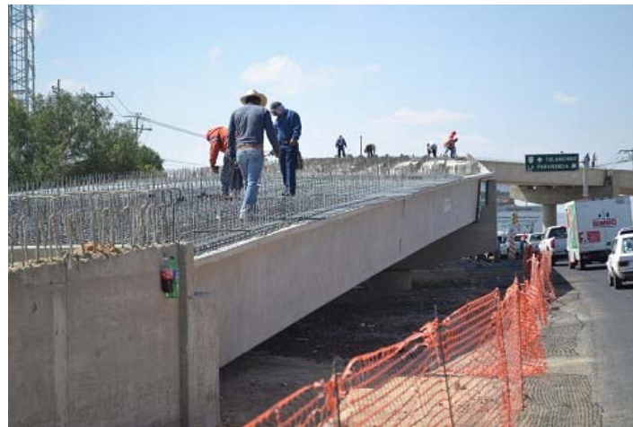
Figura 2.20 Armado de firme estructural.
