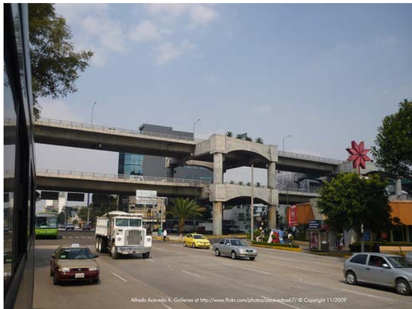
Figura 2.10 Configuración longitudinal tipo marco dos niveles.
