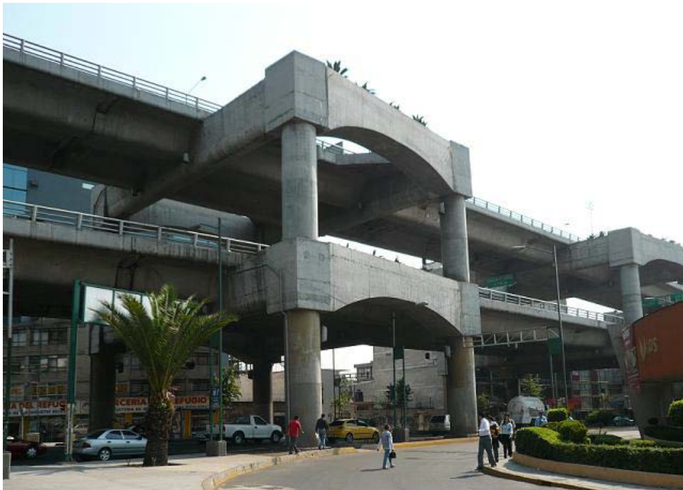
Fig. 1.1 Sistema estructural formado por marcos de concreto de dos niveles.
