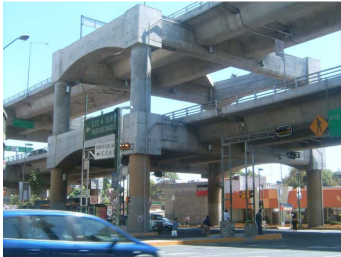
Figura 2.9 Configuración transversal tipo marco dos niveles.
