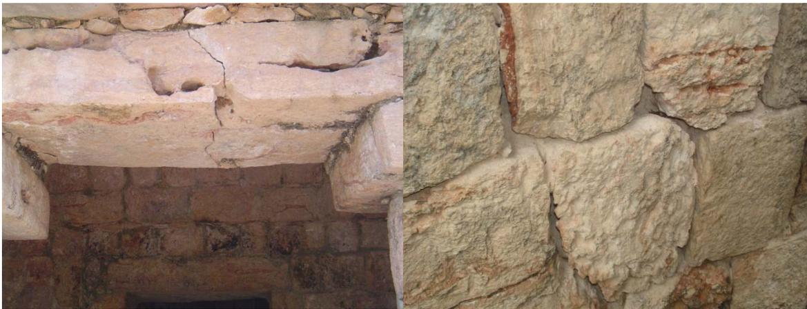
Figura No. 5.2 Grieta en dintel.      Figura No. 5.3 Deterioro en fachada.
