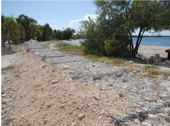
Figura No. 2.9 Muro de contención del mar Sian Ka'an.
