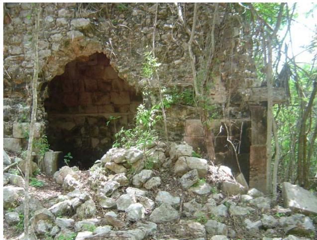
Figura No. 5.4 Deterioro causado por plantas.
