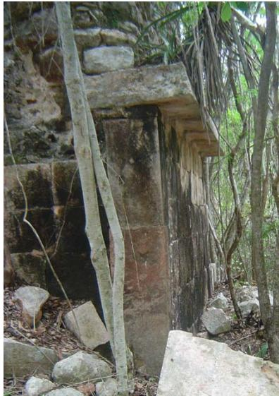
Figura. No. 5.5 Daño provocado por microorganismos.
