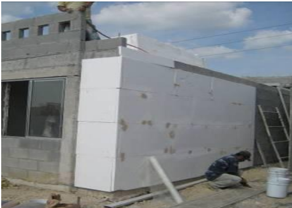
Figura 5.10 Detalle del aislante térmico en muros
