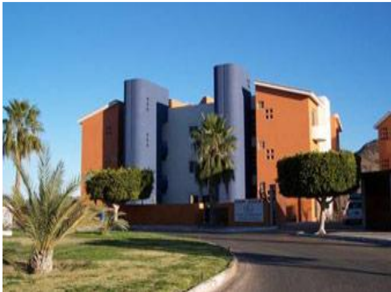
Imagen No.2.1 Vivienda sustentable
