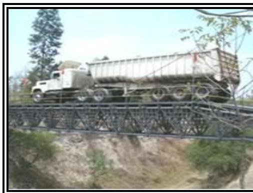
Figura No. 3.10 Puente vehicular metálico militar. Fuente: SDN.
