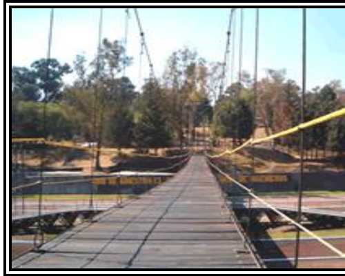
Figura No. 3.9 Puente peatonal colgante militar. Fuente: SDN.
