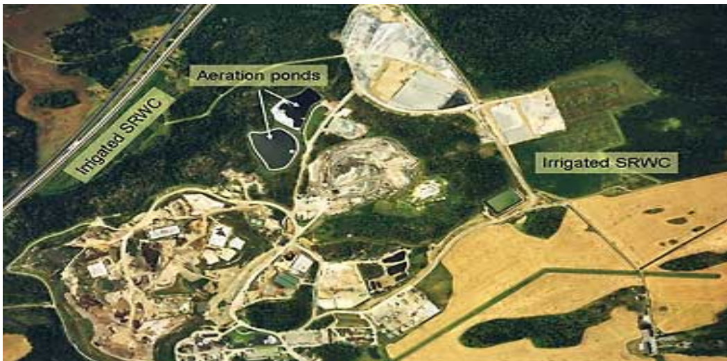
Figura 9.-Vista aérea de planta de lixiviados en Suecia.
