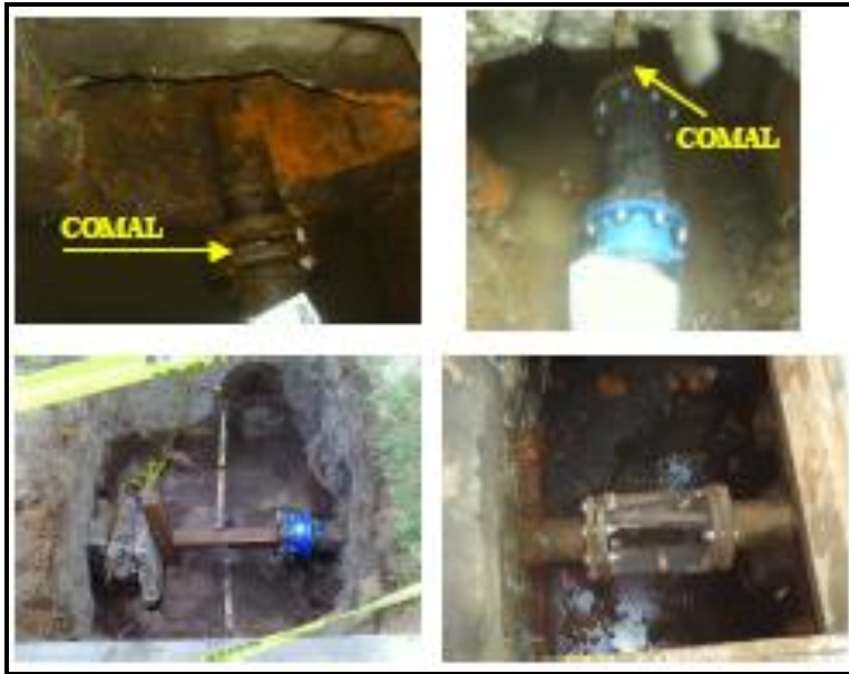
Figura 4. 28.Colocación de tapas ciegas en cajas de crueros.
