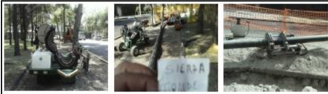
Figura 4. 37. Termofusión de la tubería de polietileno RD 17
