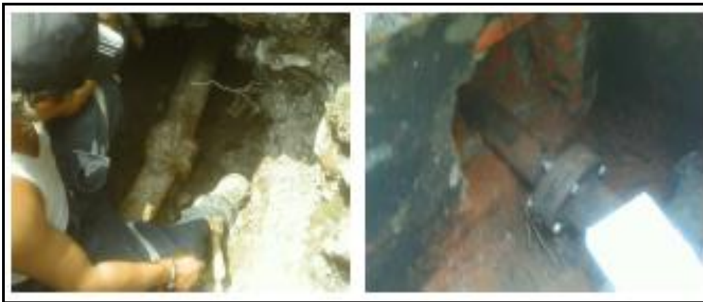
Figura 4. 31.Demolición de muros para instalación de tapa ciega.
