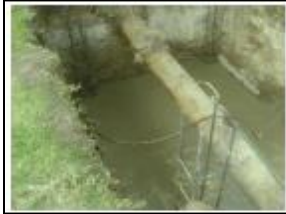
Figura 4. 16. Colado de losa de fondo de la VRP-04.
