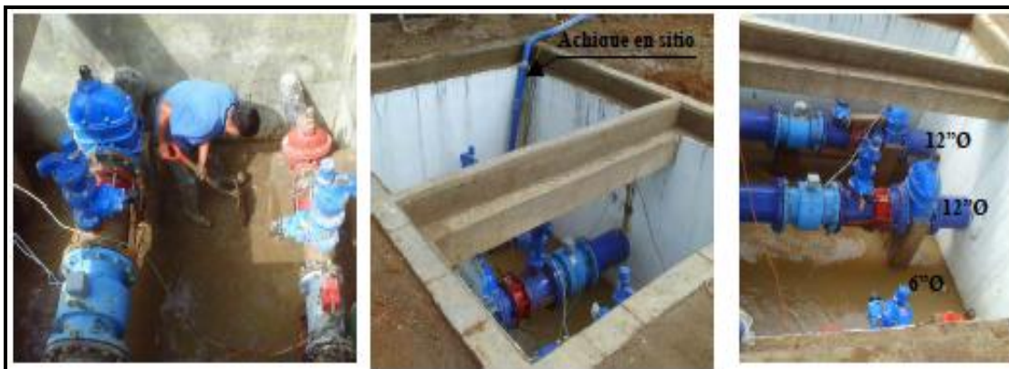
Figura 4. 3. Tren de piezas en la caja de Medición, Sector Lomas
