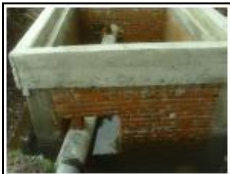
Figura 4. 18. Caja que aloja la VRP de 305mm (12") Ø.
