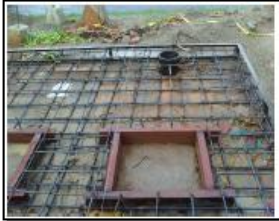
Figura 4. 4. Armado de losa tapa para la caja de medición
