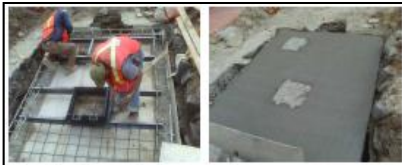
Figura 4. 26. Construcción y colado de losa tapa del sitio de interconexión.
