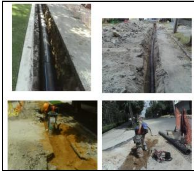
Figura 4. 39. Colocación de la tubería y relleno de las zanjas.
