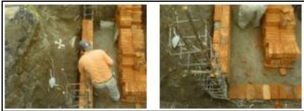
Figura 4. 17. Construcción de muros de la caja de VRP-04.
