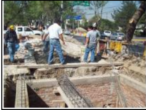
Figura 4. 2. Construcción de caja de Medición en la zona de Manómetros
