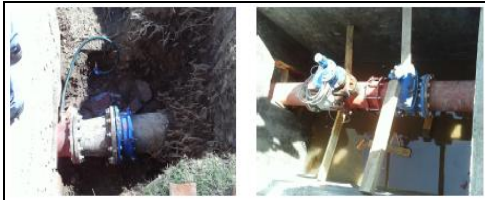
Figura 4. 7. Tren de Piezas Especiales y Medidor en el cruce de av. Paseo de las Palmas y Sierra Vertientes.
