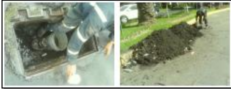
Figura 4. 30.Limpieza de cajas para operación de válvulas.
