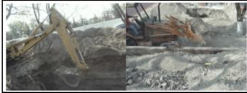
Figura 4. 10. Excavación para la zona de Control en el sitio Manómetros
