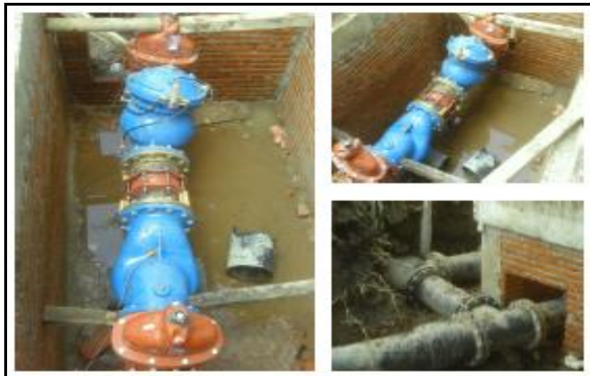
Figura 4. 20.Tren de piezas especiales de la VRP-04
