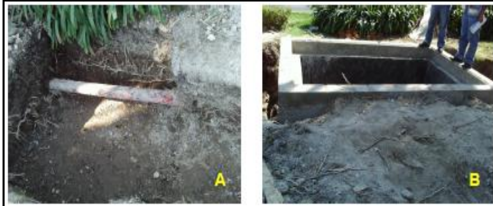
Figura 4. 6.Excavación y caja terminada para el sitio de Medición en Av. Palmas
