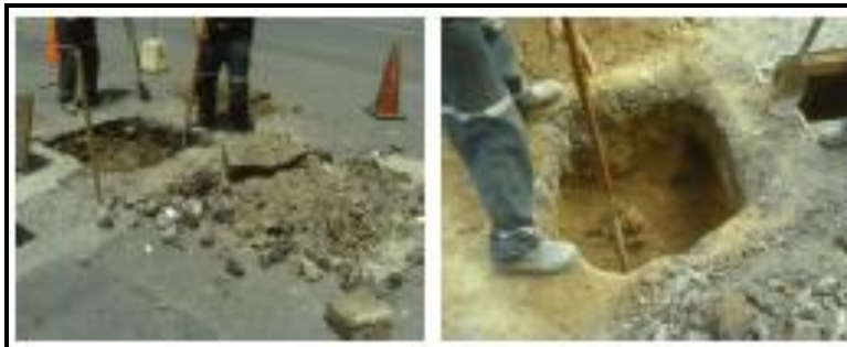
Figura 4. 29.Calas de verificación para localización de tubería en crueros.
