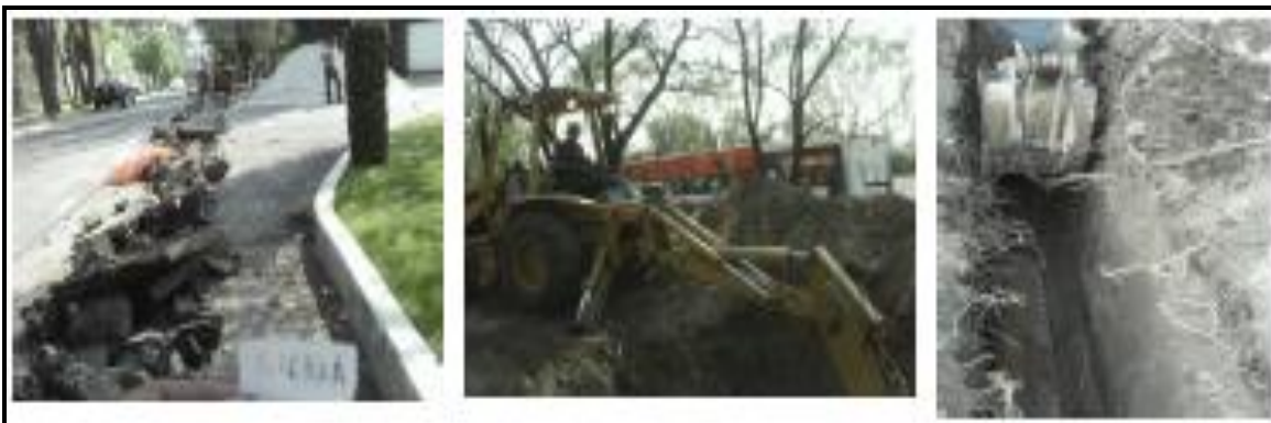
Figura 4. 35. Ruptura de pavimentos para la instalación de tuberías.
