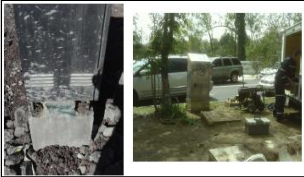
Figura 4. 42. Colocación de gabinetes y equipo de medición en el Sector Lomas
