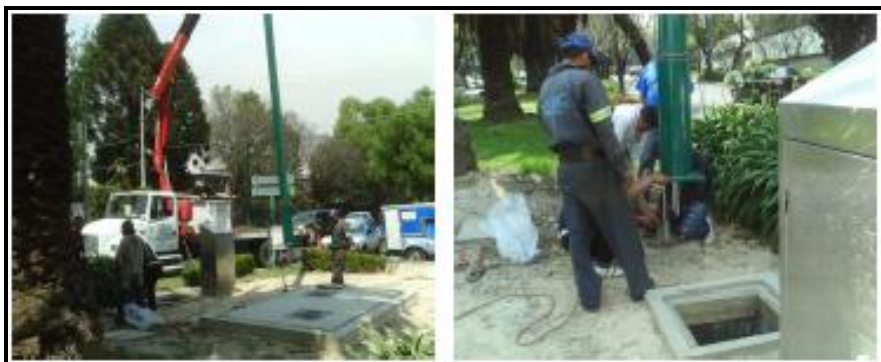
Figura 4. 44.Colocación de postes en el sitio de medición del Sector Lomas.
