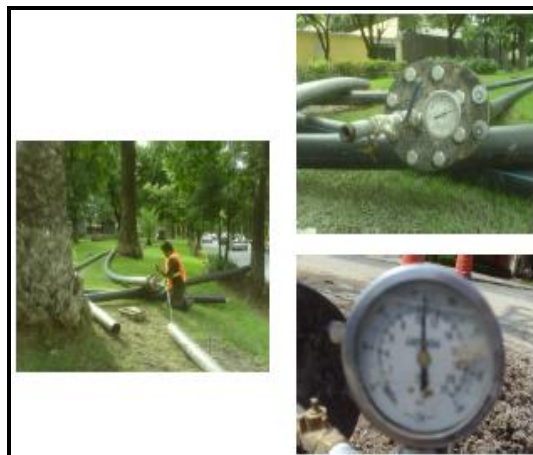
Figura 4. 38. Pruebas Hidrostáticas
