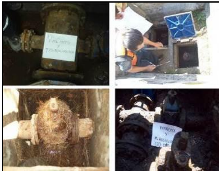
Figura 3. 7. Inspección de las cajas de cruceros en el Sector Lomas
