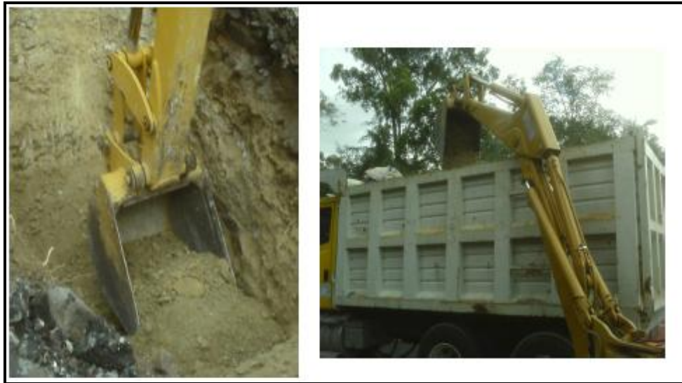
Figura 4. 15. Retiro de material producto de la excavación para alojar la caja de la VRP-04.
