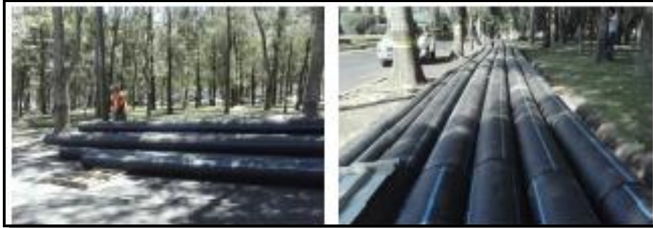
Figura 4. 36. Tuberíade polietileno RD17 para separar los subsectores
