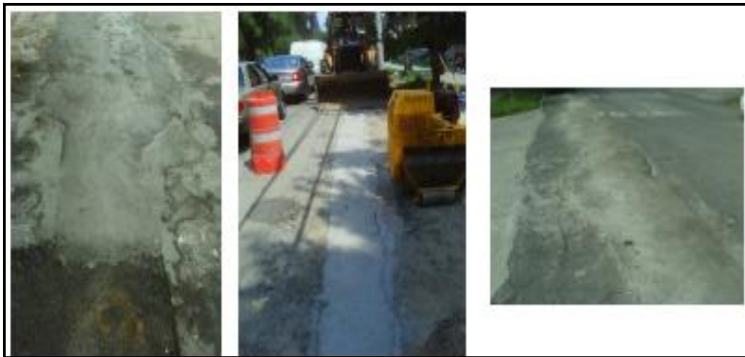
Figura 4. 40. Colocación de asfalto en vialidades, donde se instalaron tuberías
