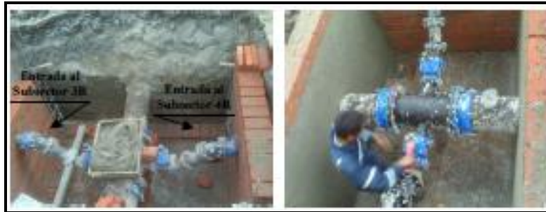
Figura 4. 25. Construcción de la caja y arreglo hidráulico de interconexión.
