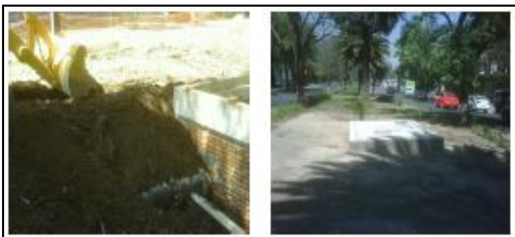
Figura 4. 22. Relleno y colocación de losa tapa de la VRP-04
