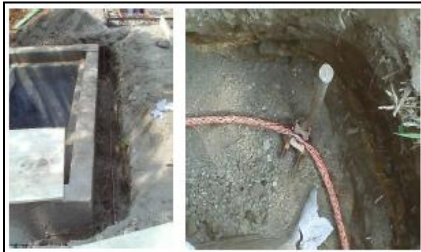
Figura 4. 43. Habilitado del sistema de tierras en el sitio de medición del Sector Lomas
