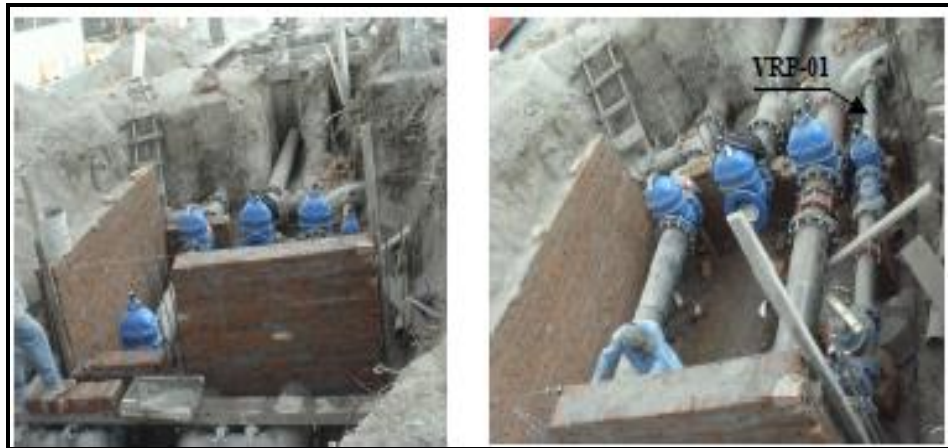
Figura 4. 11. Construcción de caja y trabajos de fontanería de Piezas Especiales en el sitio de Regulación en la zona de Manómetros
