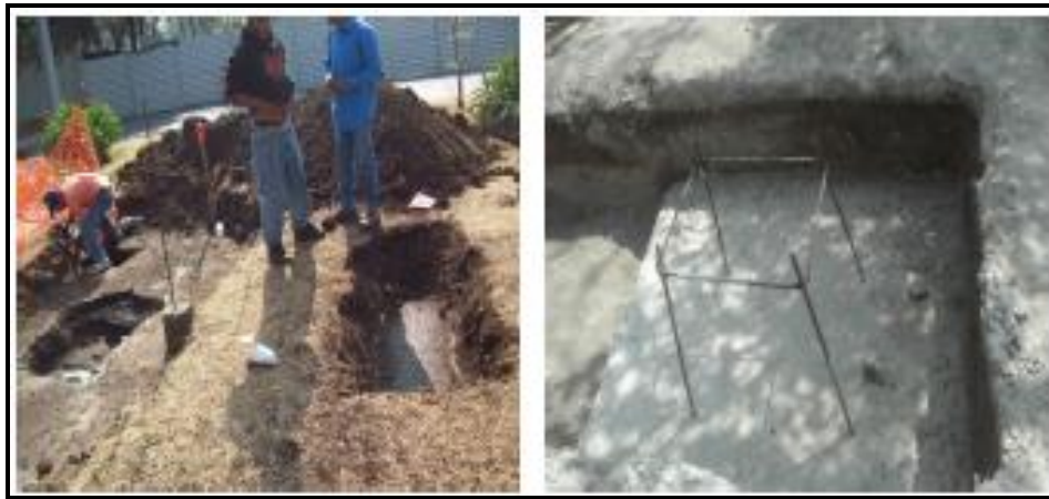
Figura 4. 41. Construcción de bases para gabinetes y postes de medición.
