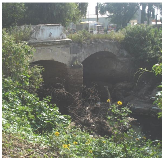
Figura 19. Puente de la Avenida San Antonio.
