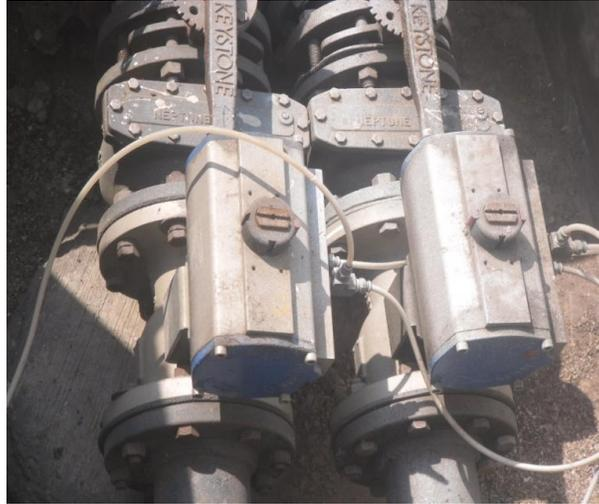
**Figura 2.4. Válvulas con actuador neumático.**
