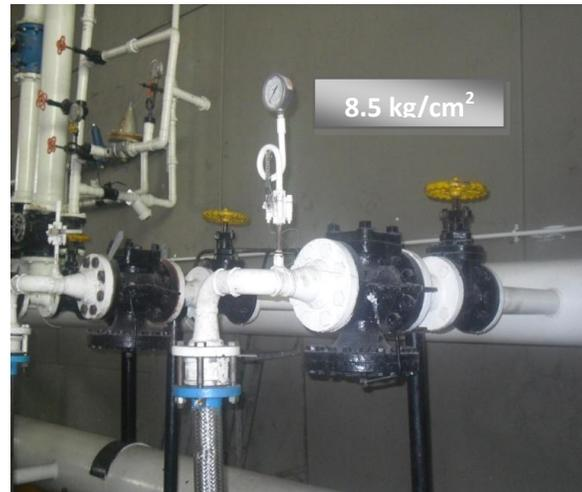
**Figura 2.15. Medición de presión en la descarga de la bomba-cabezal.**
