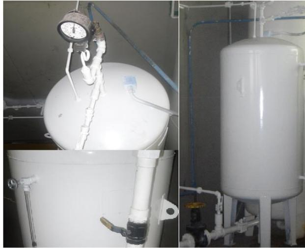
Figura 2.17. Tanque hidroneumático instrumentado.
