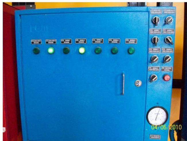
Figura 3.14. Indicadores luminosos y perillas selectoras del tablero.
