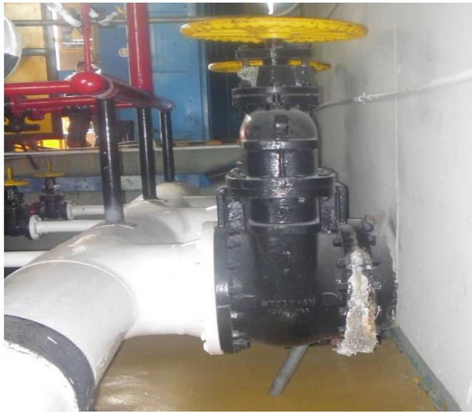
Figura 2.7 Conexión entre el cabezal de succión y las cisternas.
