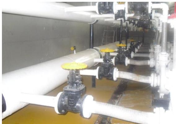
Figura 2.12. Conexión entre cabezal de succión y bombas.
