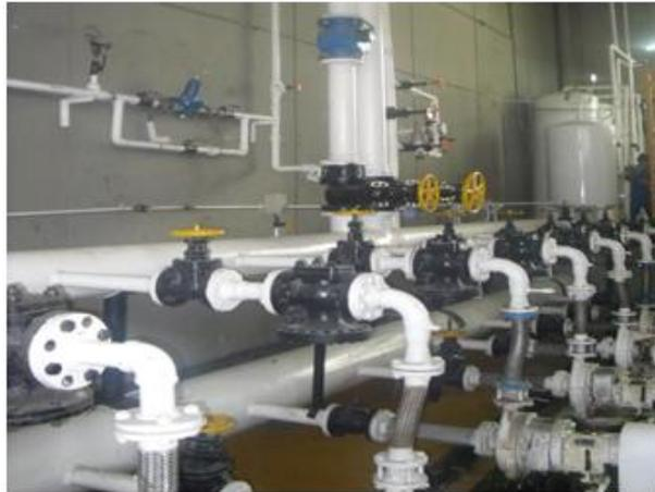
**Figura 2.13. Conexión de la descarga de las bombas y el cabezal de descarga.**
