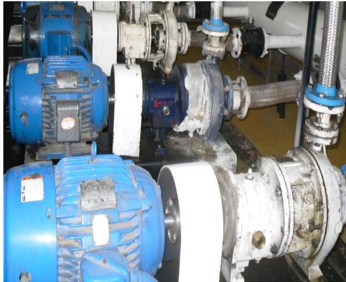
Figura 2.9. Acoplamiento motor-bomba.
