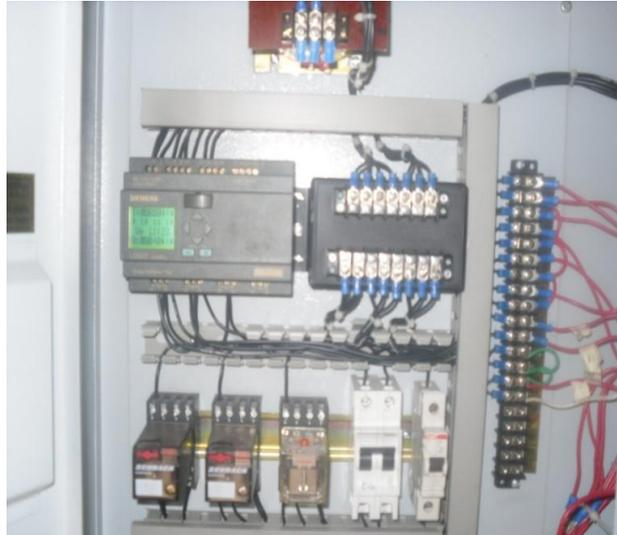
**Figura 2.6 PLC de las bombas mediadoras.**
