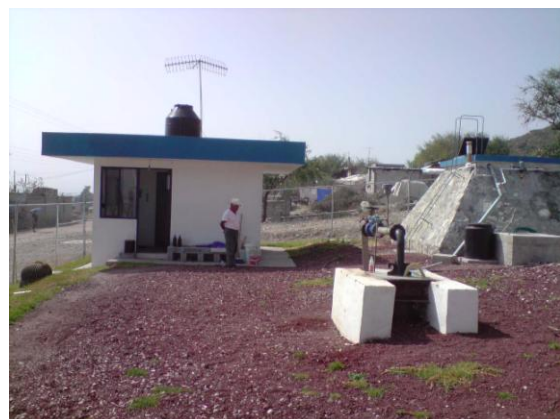
Fig. 17 Vista al cuarto de controles y vigilancia así como tanque de almacenamiento.
