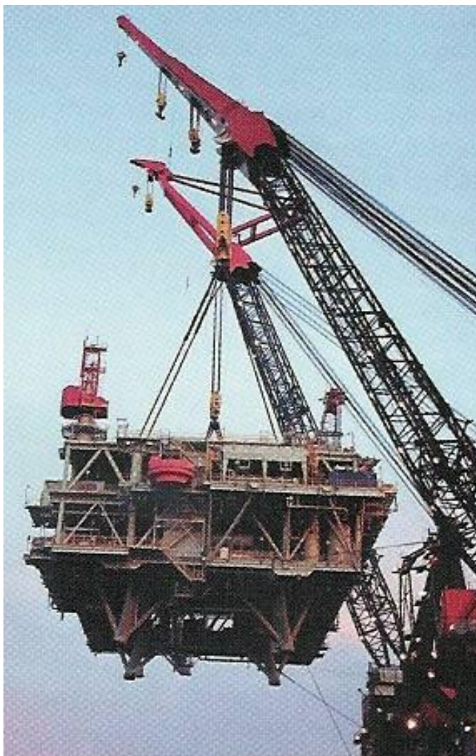
Fig. 1.6 Colocación del deck
