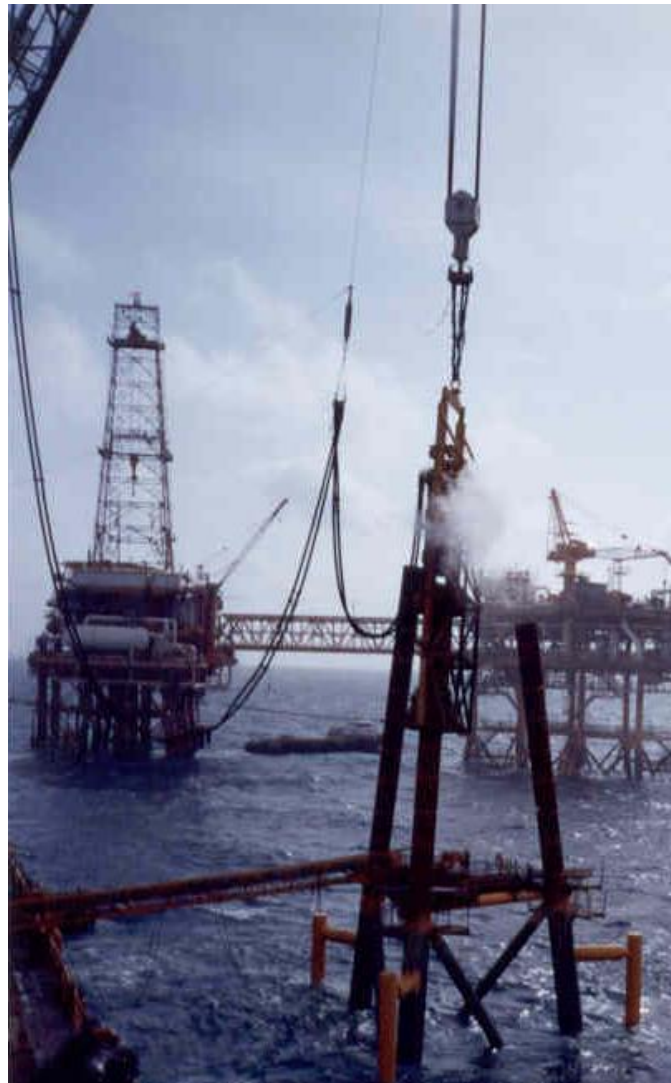
Fig. 1.5 Hincado de pilotes (Ibarra y Luna, 2000)
