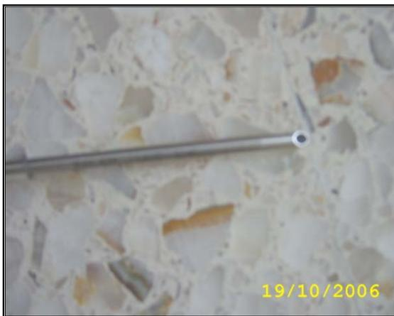
Figura 19.- Aguja que perfora la tapa del producto para la inyección de agua.
