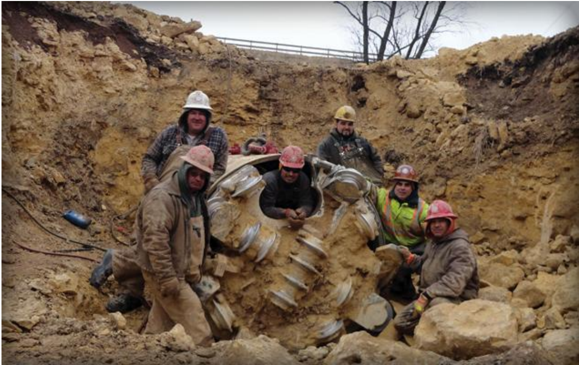
Imagen 2 - 22. Salida de la Tuneladora.
