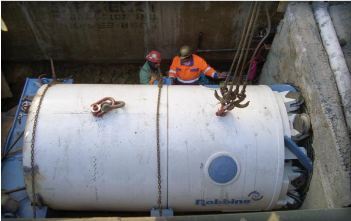
Imagen 2 - 21. Bajada de la Tuneladora.
