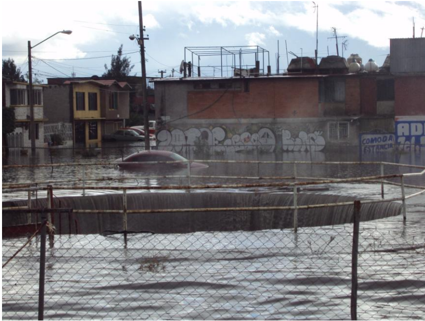
Imagen 5 - 2. Afectaciones viviendas inundadas.
