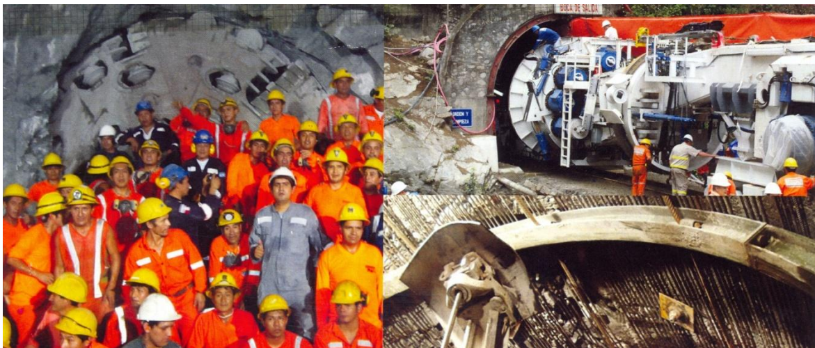
Imagen 2 - 23. De izquierda a derecha: el personal de Odebrecht celebra la llegada de la Robbins TBM al final del túnel; puesta en marcha de la tuneladora en 2007; listones de varillas de acero que sostiene las piedras sueltas en la corona.
