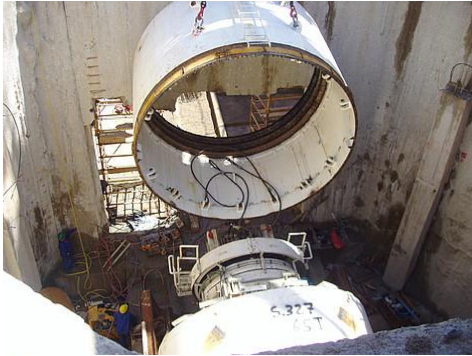
Imagen 2 - 16. Bajada de las partes del escudo S-327.
