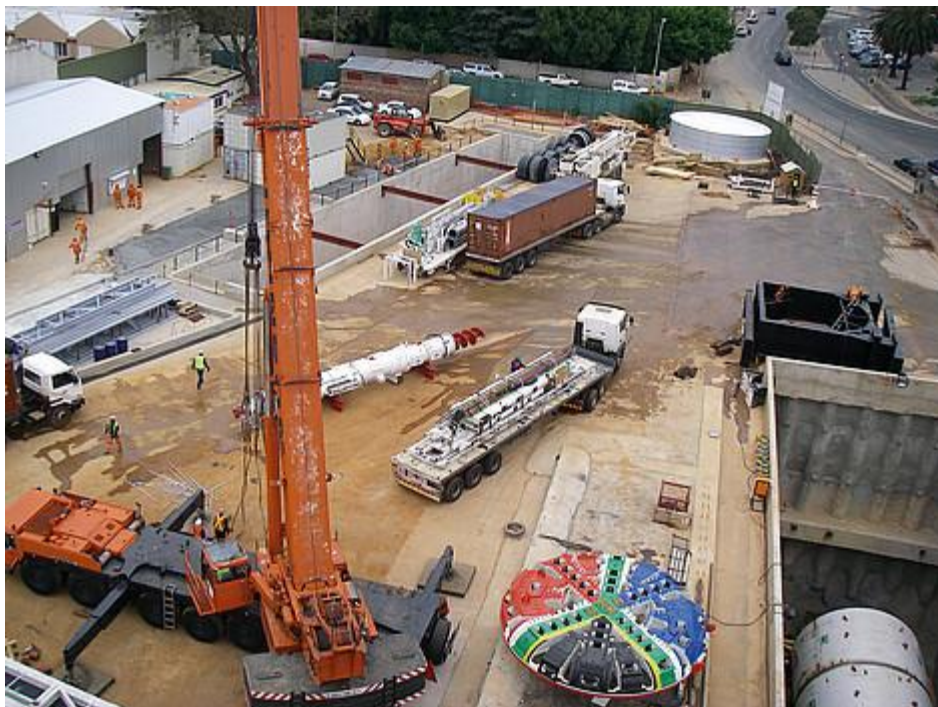
Imagen 2 - 19. Bajada de las partes del escudo Imbokodo.
