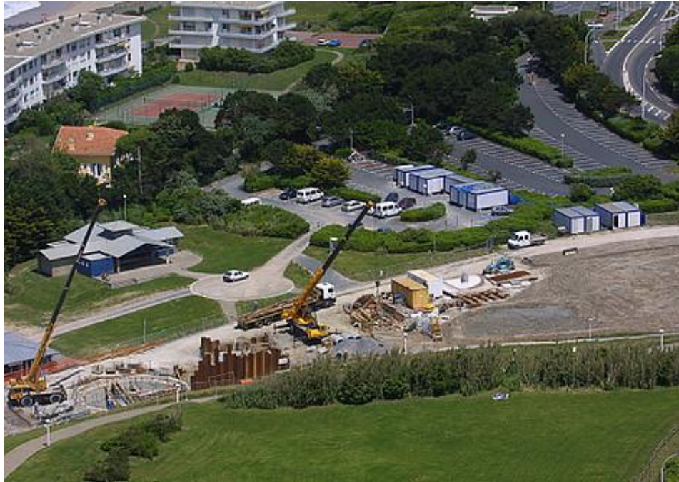
Imagen 2 - 2. Vista aérea de la construcción de la planta de tratamiento.
