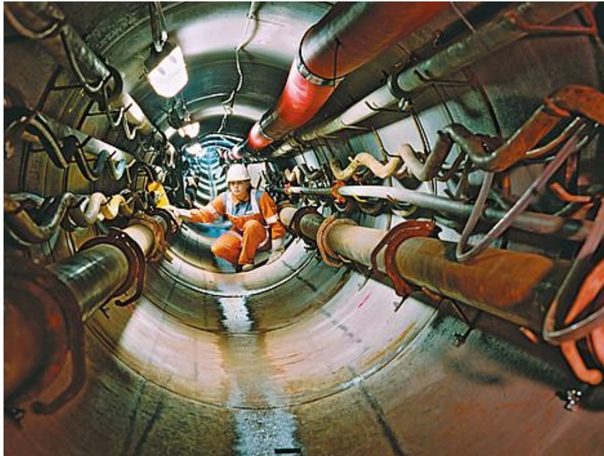
Imagen 2 - 5. Vista del interior del túnel.
