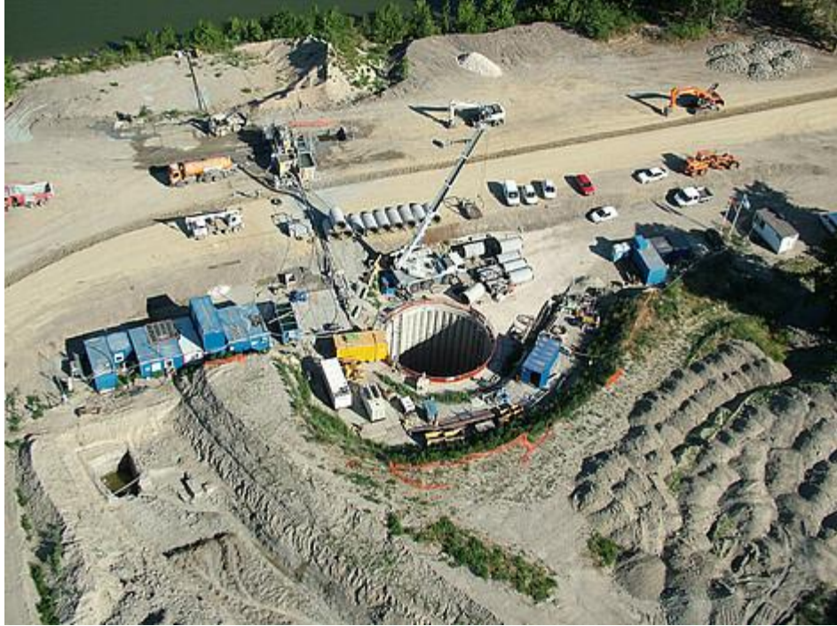
Imagen 2 - 6. Vista aérea de la obra.
