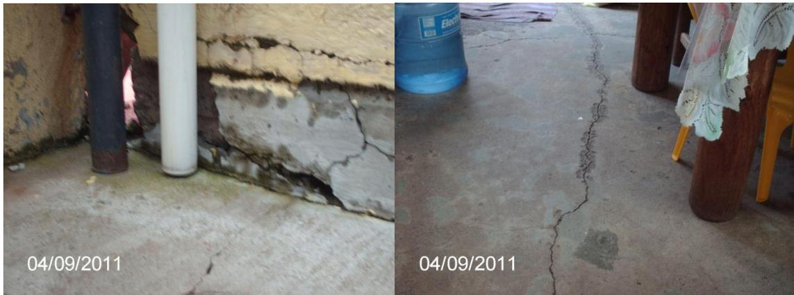
*Fig. 4.36 Cuarteaduras dentro de las casas debido a la inestabilidad del suelo*
