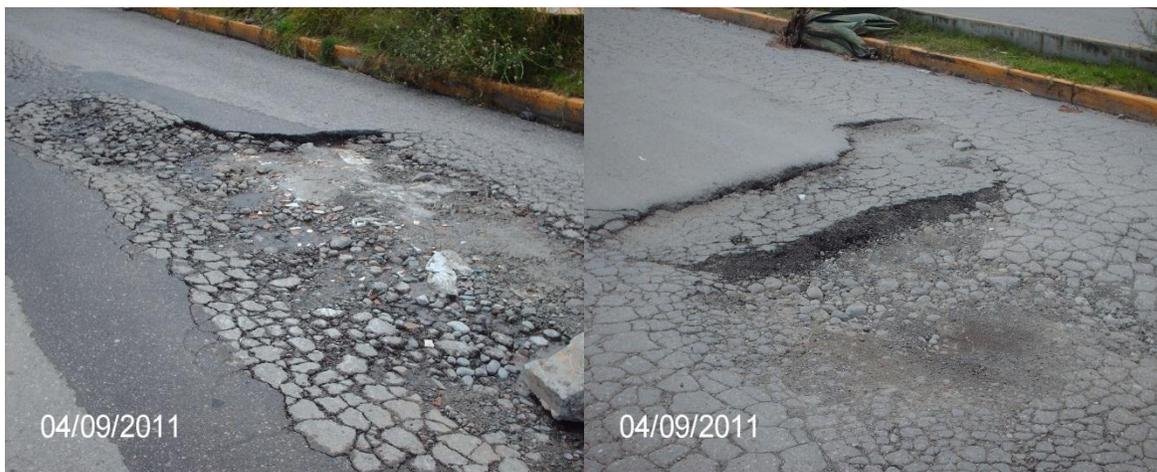
Fig. 4.35 Fotos tomadas en campo de las zonas con hundimientos y agrietamientos
