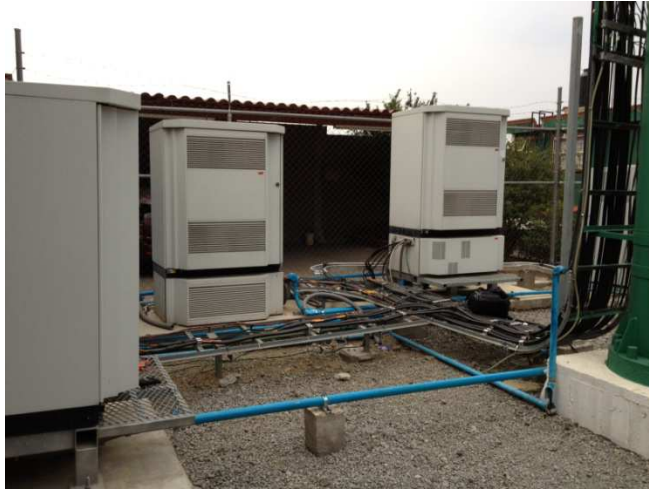
Figura 3.3 BTS de tipo Outdoor
