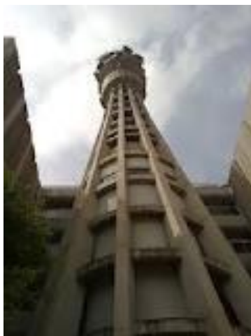
Figura 2. Centro Telefónico San Juan
