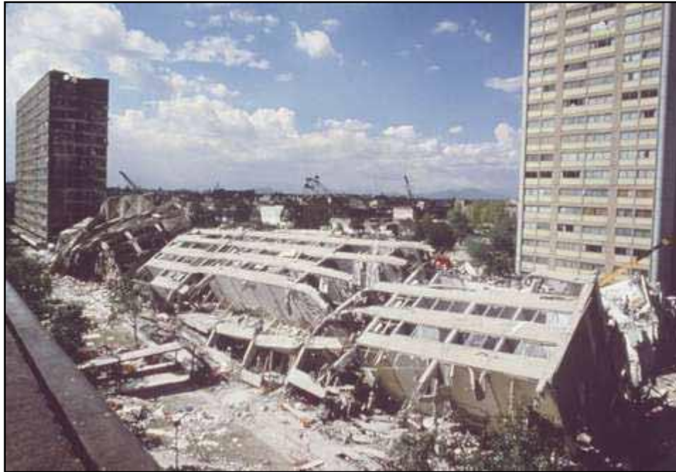
Imagen 2- 21: Edificio derrumbado en Tlatelolco, 1985
