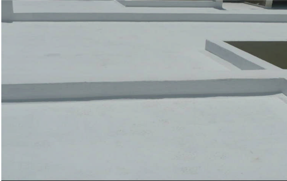
Fig. N° 49_ Impermeabilización de losa de azotea, chaflanes y pretiles con plasticool.
