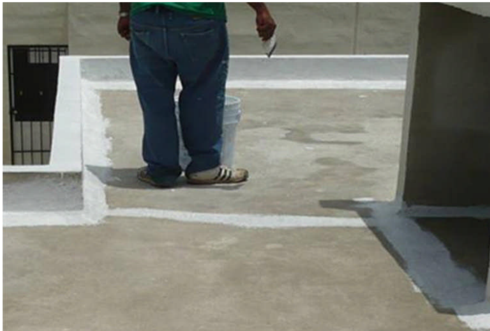
Fig. N° 48 _ Sellado de grietas en losa, chaflanes y pretiles
