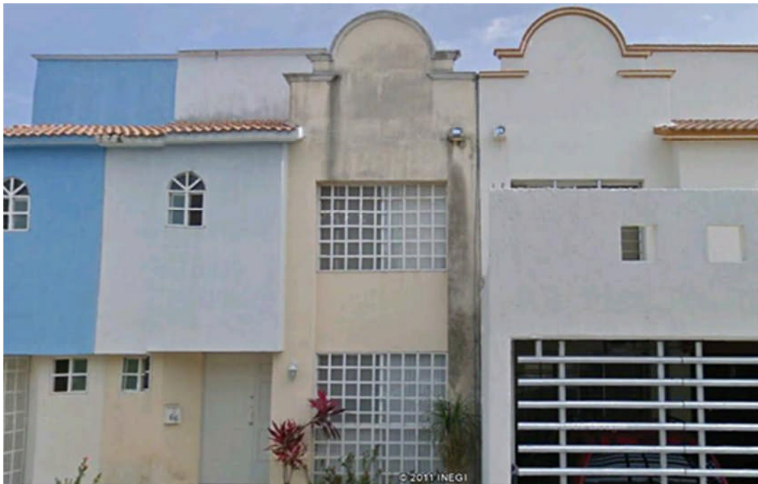
Fig. N° 38 _ Vivienda del Fraccionamiento Porto Bello
