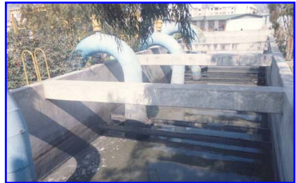
Fig No 2.1.8. CAJA DE DESCARGA.
