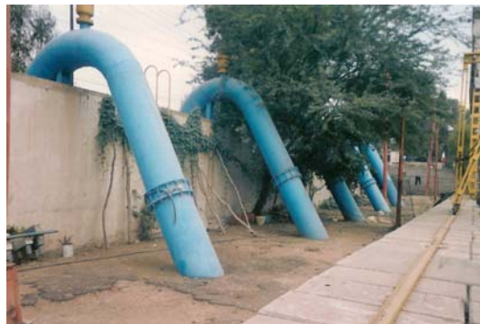
Fig No 2.1.7.TUBERIAS DE DESCARGA.
