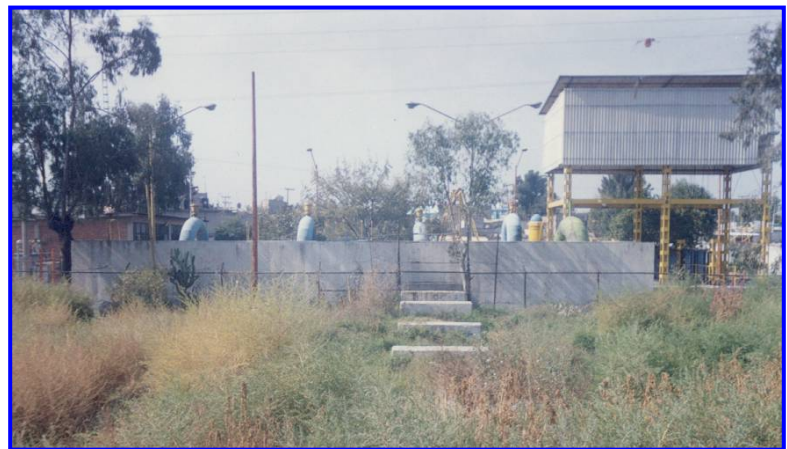
Fig No 2.1.9. DE IZQUIERDA A DERECHA.- TUBERIAS DE DESALOJO DEL TANQUE AL RIO "LA COMPAÑÍA" DE 24" Y 36 "DE DIAMETRO RESPECTIVAMENTE.
