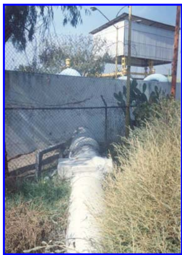
Fig No 2.1.9. DE IZQUIERDA A DERECHA.- TUBERIAS DE DESALOJO DEL TANQUE AL RIO "LA COMPAÑÍA" DE 24" Y 36 "DE DIAMETRO RESPECTIVAMENTE.
