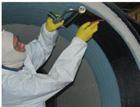
*Fig. 29. Aplicación de recubrimientos anticorrosivos.*
