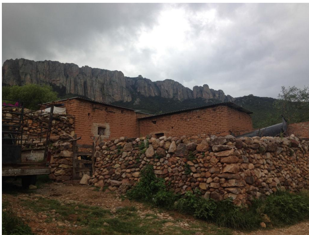
Figura1: Se pueden observar en la imagen, los rasgos representativos de la arquitectura de las viviendas tradicionales de localidad San Nicolás, los sistemas constructivos a base de piedra y adobe, las proporciones en puertas y ventanas a base de madera, la forma y disposición de los aposentos y la altura promedio de las viviendas. Fotografía de A. Velasco (2015)
