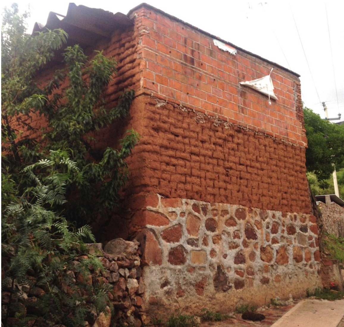
Figura 2: Vivienda tradicional en la localidad de Sn Nicolás, Colotlán en el estado de Jalisco, se pueden apreciar la cantidad de incorporaciones de materiales industrializados, de arriba hacia abajo respectivamente es notoria la inclusión de Lamina de asbesto en sustitución de la cubierta tradicional de teja, bloques prefabricados en combinación con los sistemas constructivos tradicionales. adobe (sistema tradicional) y piedra (tradicional ). Fotografía de A. Velasco (2015)
