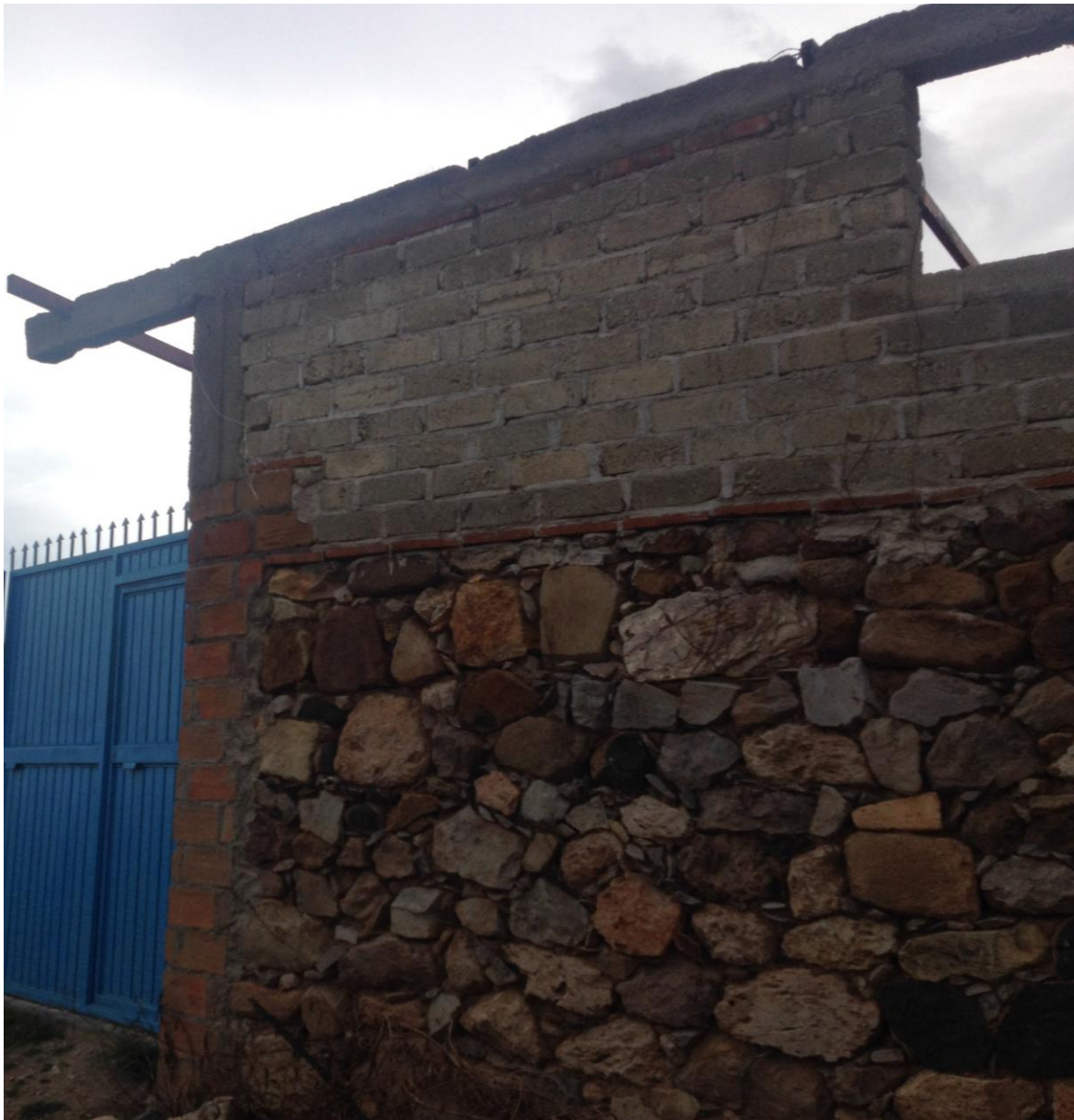
Figura 3: Vivienda tradicional en la localidad de Sn Nicolás, Colotlán en el estado de Jalisco Fotografía de A. Velasco (2015)
