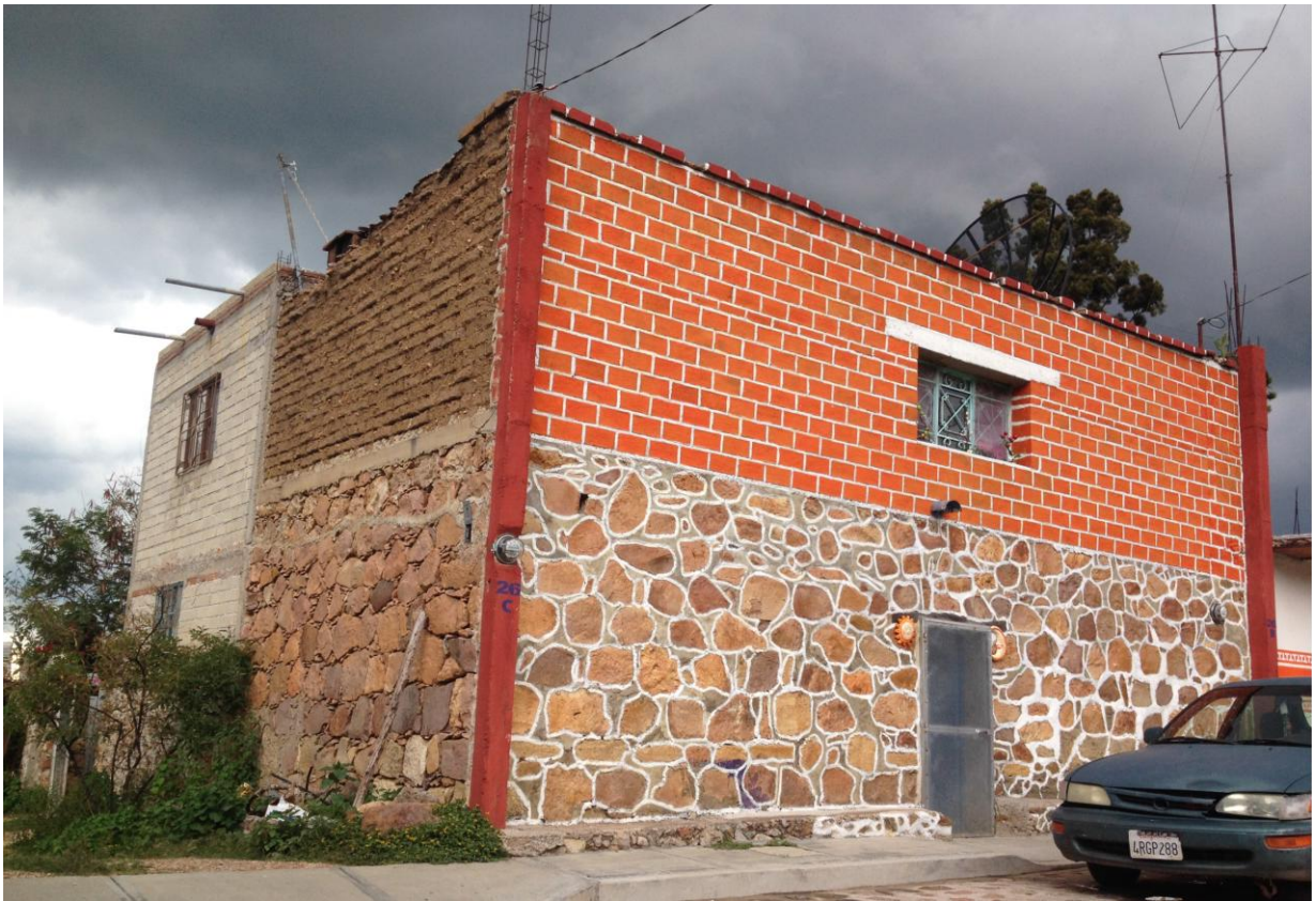
Figura 4: Vivienda tradicional en la localidad de Sn Nicolás, Colotlán en el estado de Jalisco Fotografía de A. Velasco (2015)
