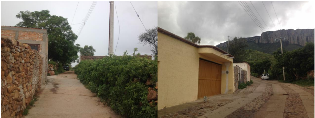
Figura 5: Vivienda tradicional en la localidad de Sn Nicolás, Colotlán en el estado de Jalisco Fotografía de A. Velasco (2015)
