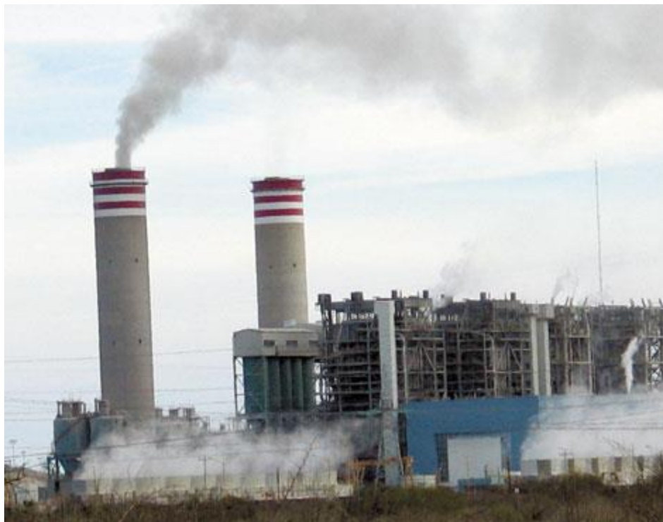
Figura 3. Central carboeléctrica, Nava Coahuila.
